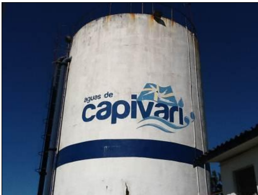
Figura 10: Escadas para acesso superior.
