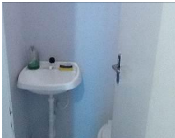
Figura 3: Sanitários para Funcionários.
