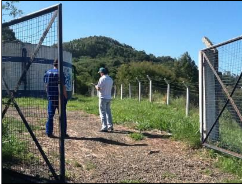
Figura 15: Entrada da Unidade dispõe de portão com cadeado.
