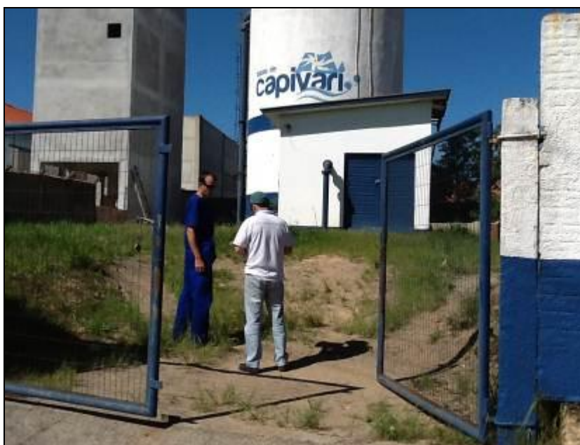
Figura 9: Reservatório sem identificação.
