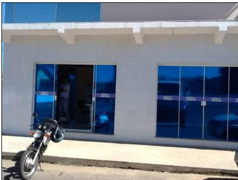
Figura 1: Fachada do Escritório da Concessionária.
