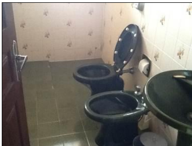
Sanitário do Escritório.
