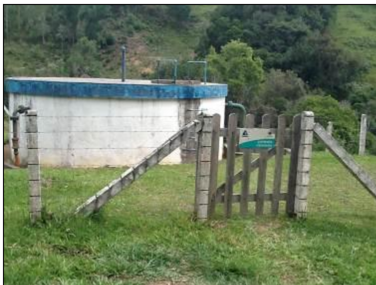
Entrada da ETA
