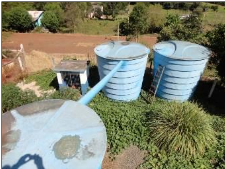
Figura 21: Cobertura dos Reservatórios
