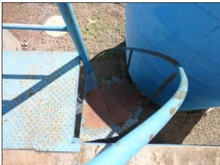
Figura 11: Escada de Acesso ETA
