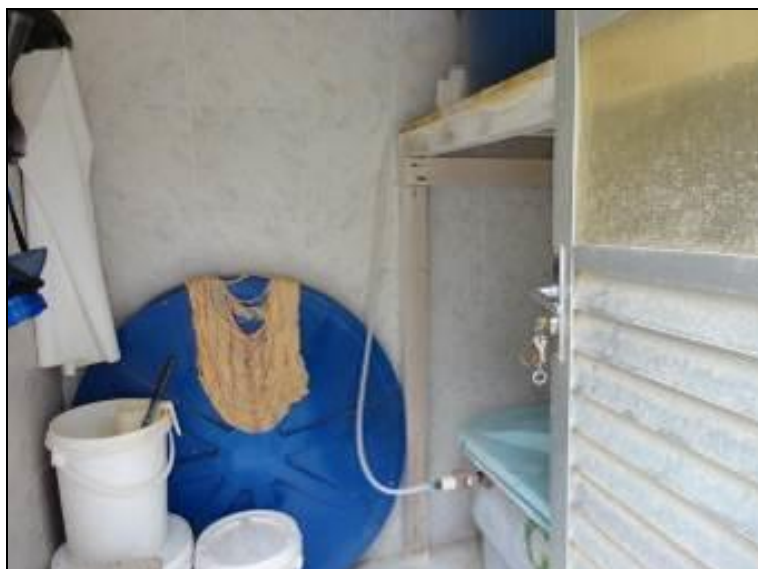
Figura 15: Guarda dos produtos químicos
