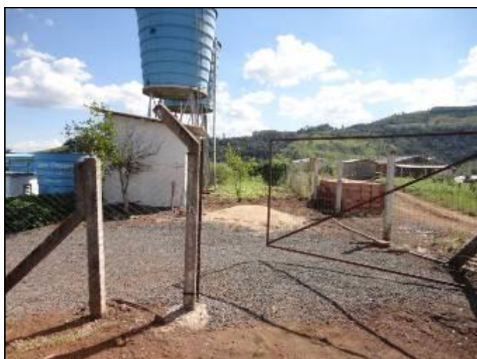
Figura 8: Acesso a ETA
