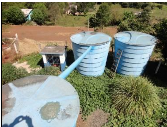
Figura 18: Entorno do reservatório
