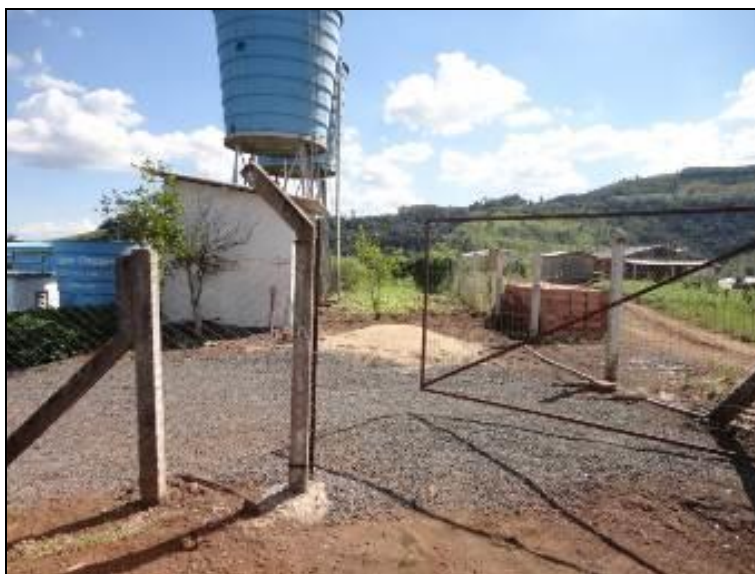
Figura 10: Cerca de Proteção ETA
