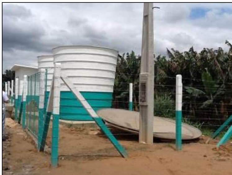
Cerca de Proteção da ETA
