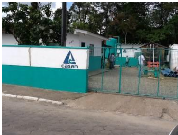
Área da ETA cercada, e identificada.
