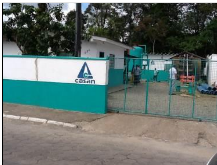
Fachada da ETA
