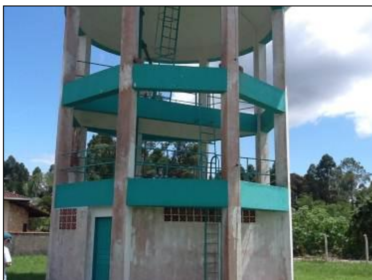
Escada de Acesso
