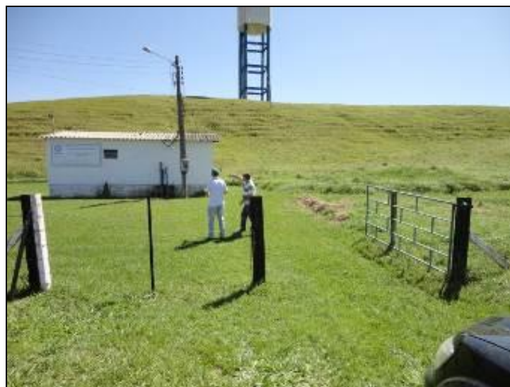
Figura 18 – Acesso ao Reservatório
