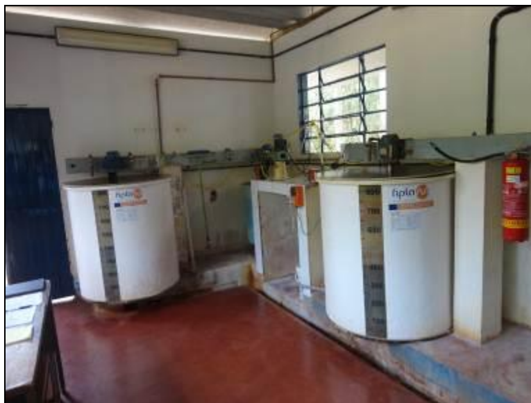
Casa de Química da ETA.
