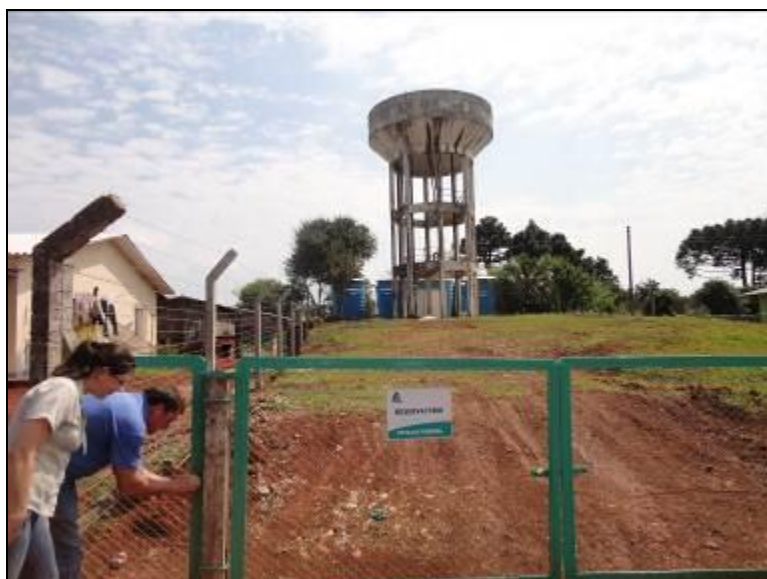
Áreas de entorno dos Reservatórios do SAA.
