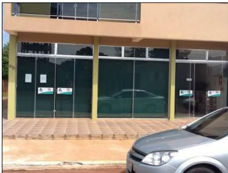
Fachada do Escritório
