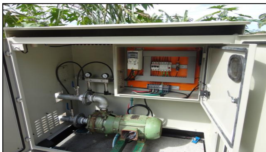
Figura15- instalação de Booster no Bairro Fundos
