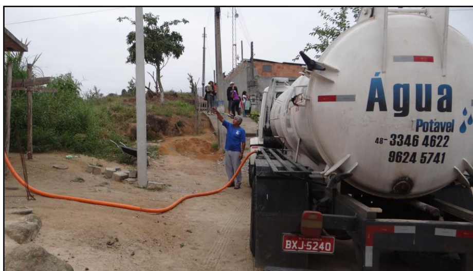
Figura 11 - Caminhão pipa abastecendo na Rua José Ferminio Mandrich
