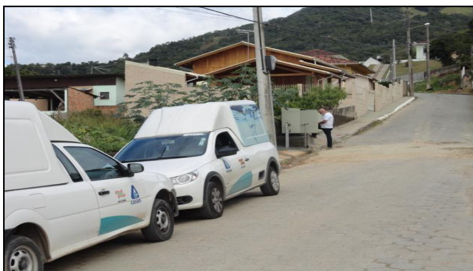
Figura 14- instalação de Booster no Bairro Fundos
