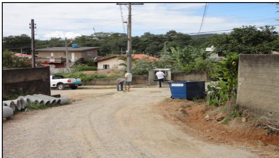
Figura 13 - instalação de Booster no Bairro Fundos
