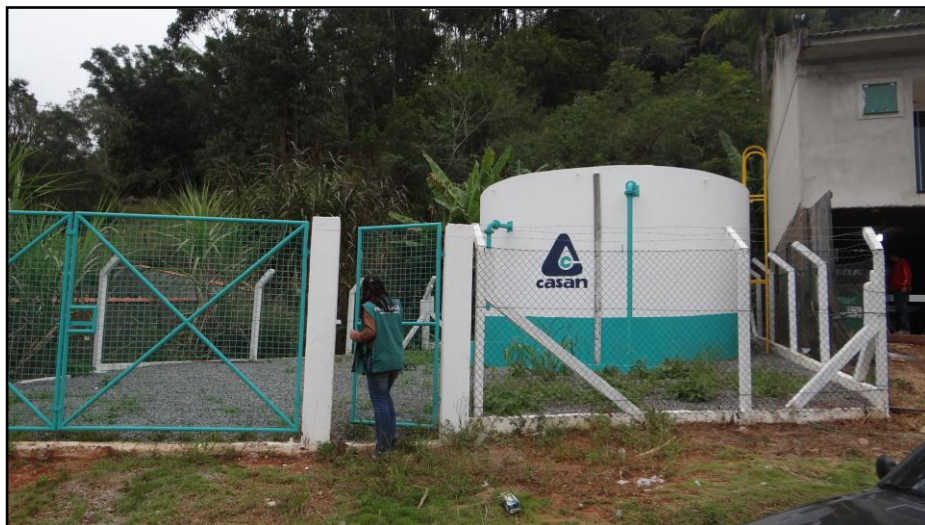
Figura 9 - Reservatório próximo à comunidade
