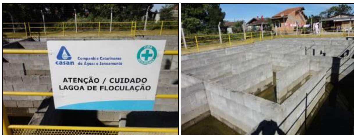
Figura 20 – Nova Lagoa de Floculação e placa de identificação. Porém ainda não está em funcionamento (ACOMPANHAMENTO)
