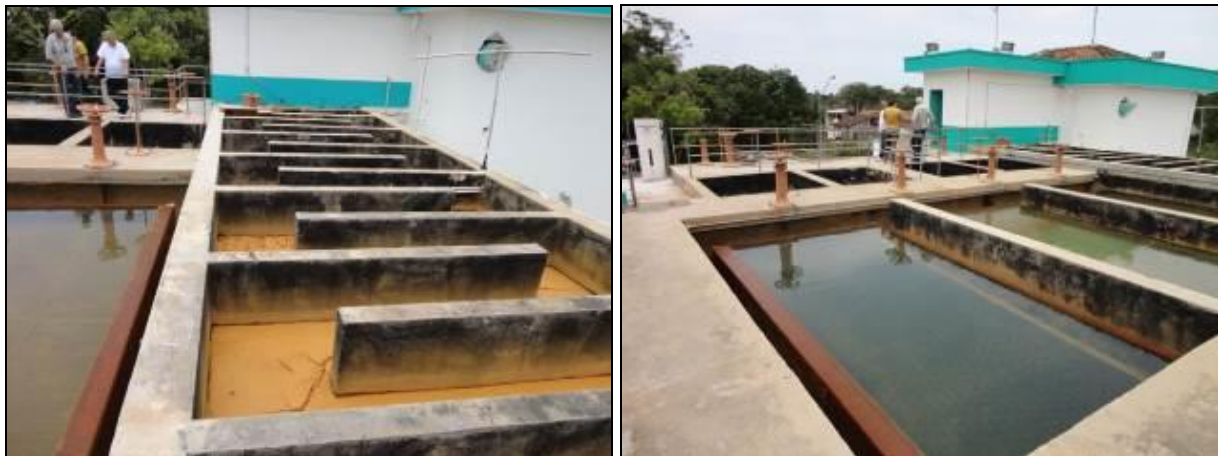
Figura 21 - Situação da ETA antiga, que será substituída (INICIAL)
