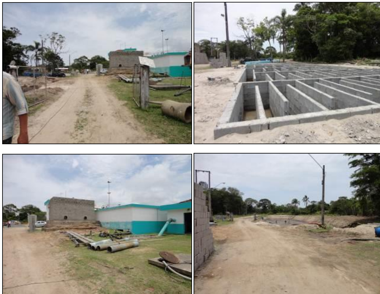
Figura 19 - Obras da Estação nova: previsão de conclusão no início de 2012 (INICIAL)
