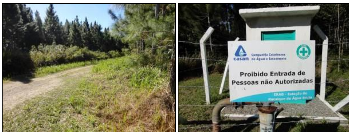
Figura 13 – Acesso ao Poço 2 e placa de identificação (ACOMPANHAMENTO)
