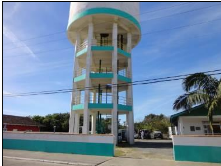
Figura 32 – Vista do R1 que funciona junto à base de operações (ACOMPANHAMENTO)
