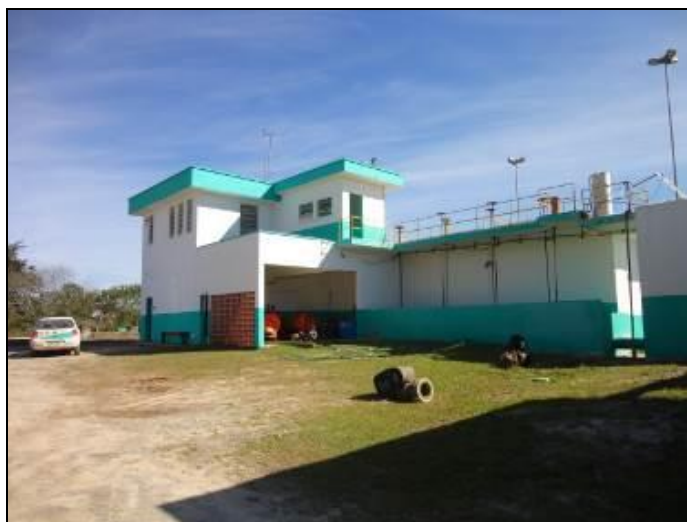
Figura 17 – Vista geral da ETA de Balneária Barra do Sul (ACOMPANHAMENTO)
