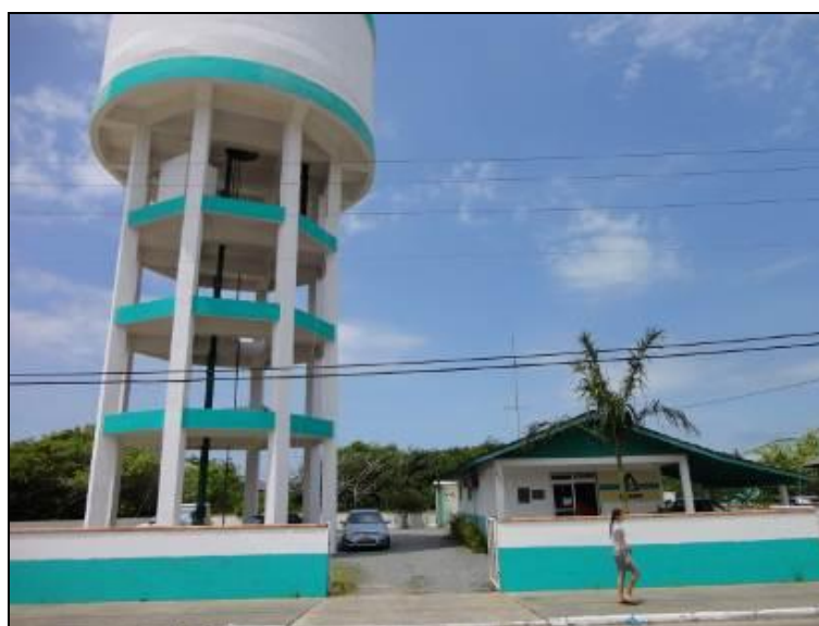
Figura 31 - Vista do único Reservatório do Sistema que funciona junto à base de operações (antiga sede da agência municipal) (INICIAL)
