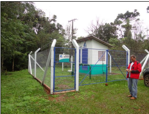
Figura 3: Captação - Poço 02- 27m 3 /h (Inicial)
