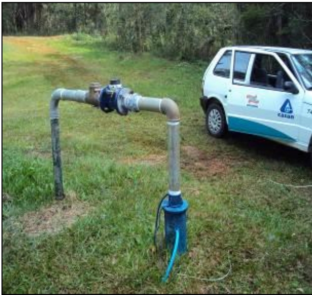
Figura 3: Captação - Poço 02- 27m 3 /h (Inicial)
