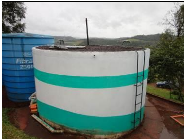
Figura 8: Escada do Reservatório
