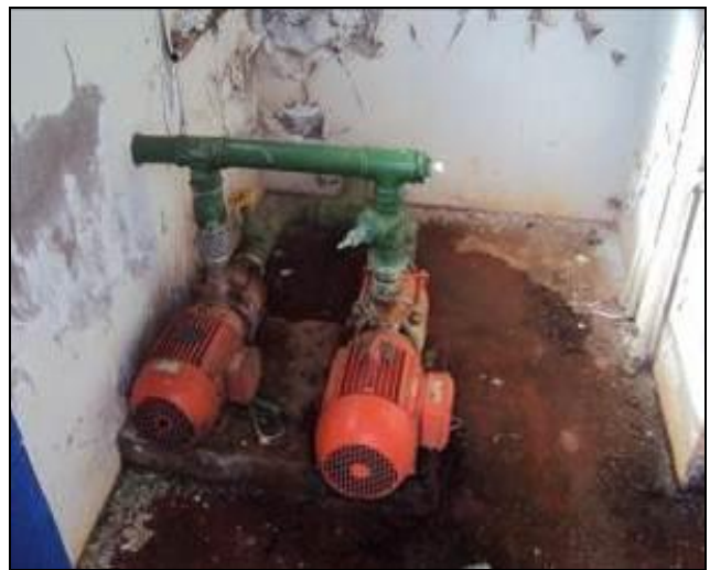
Figura 1: Captação – Poço 01- 8 m 3 /h (Inicial)
