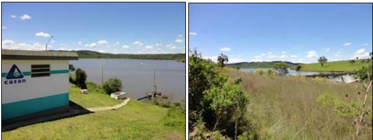
Figura 2 - Visão geral da Captação (inicial)
