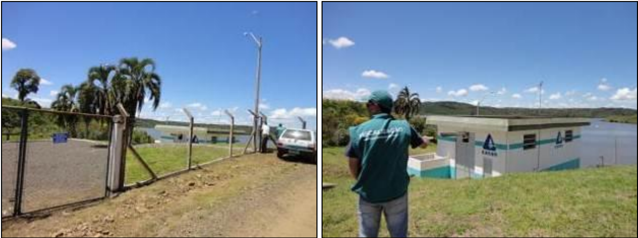
Figura 6 - Acesso via estrada vicinal, próximo à BR 116. (Inicial)
