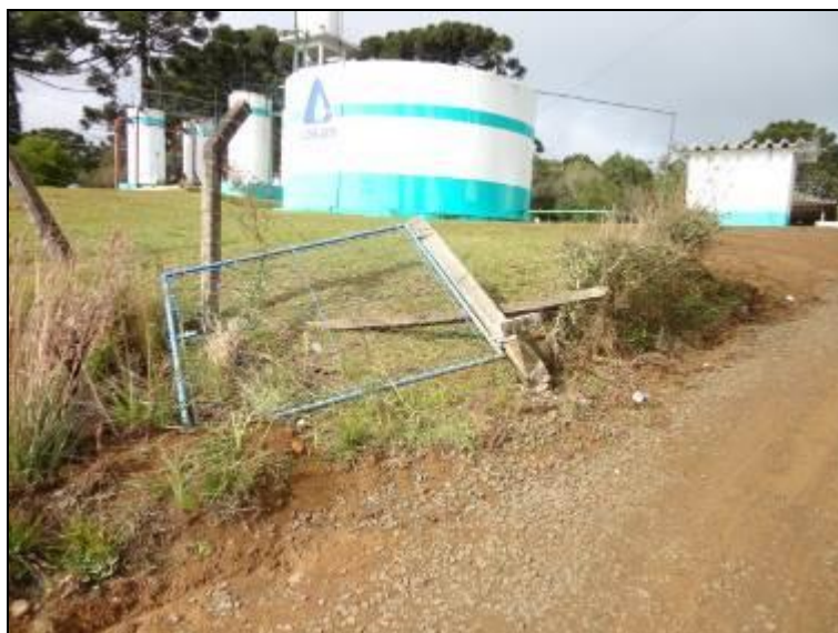
Figura 8 - Acesso a ETA junto aos Reservatórios (Acompanhamento)
