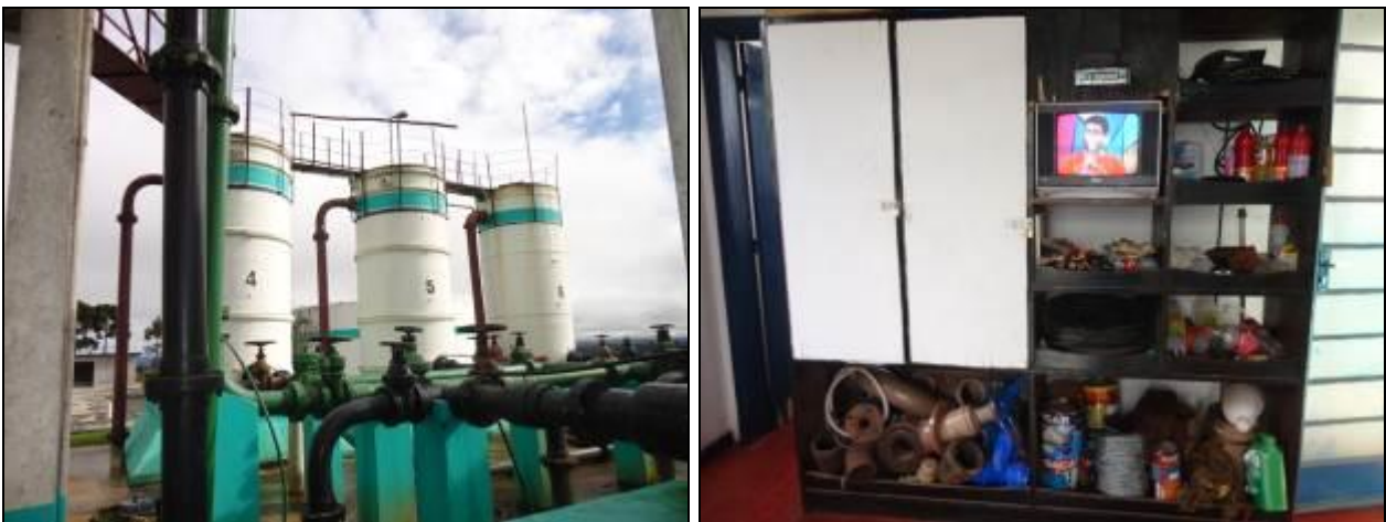
Figura 17 - Estruturas da ETA de Santa Cecília (Acompanhamento)
