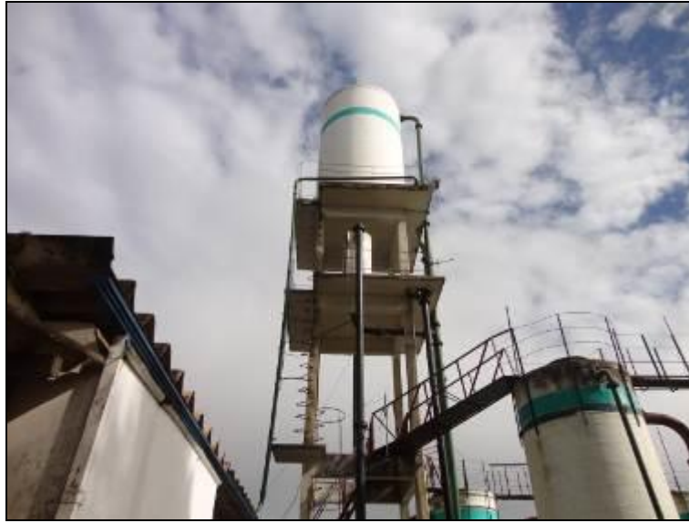
Figura 9 – Escada de Acesso ETA (Acompanhamento)
