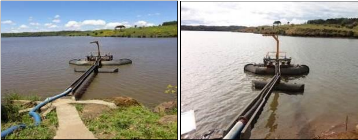
Figura 1- Bombas que fazem a captação junto a Represa (inicial e Acompanhamento)
