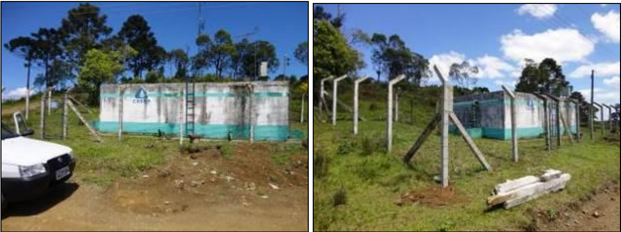
Figura 20 - Terceiro reservatório do Sistema de reservação. (inicial)
