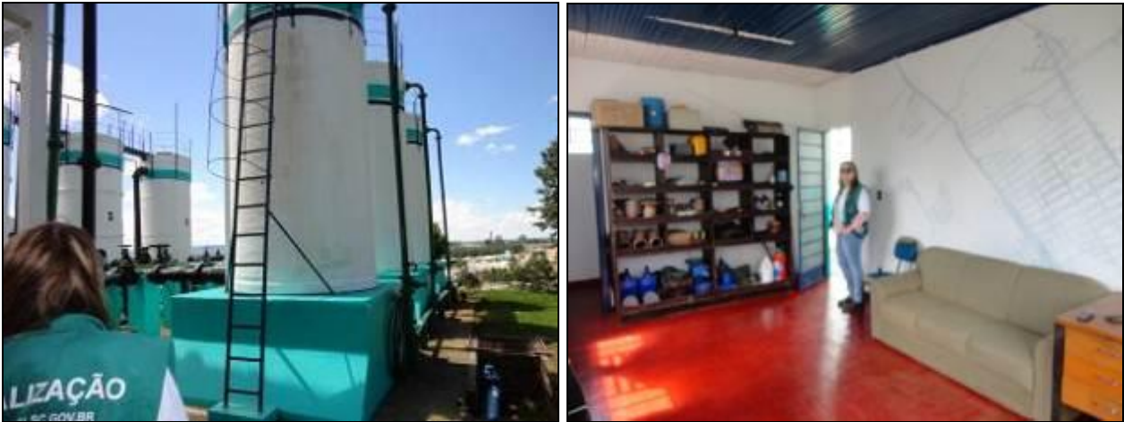
Figura 16 - Estruturas da ETA de Santa Cecília (Inicial)
