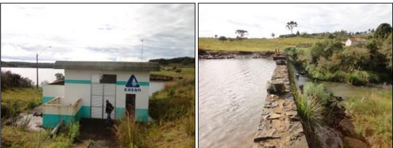
Figura 5 Captação de água bruta junto a Represa de Ubatã (acompanhamento)
