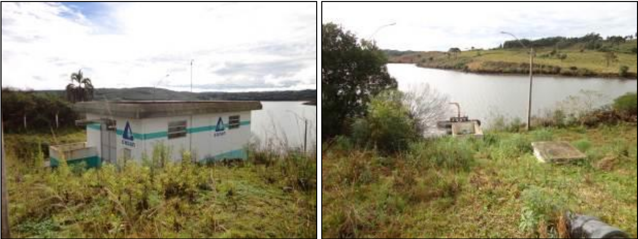
Figura 3 - Visão geral da Captação (Acompanhamento)
