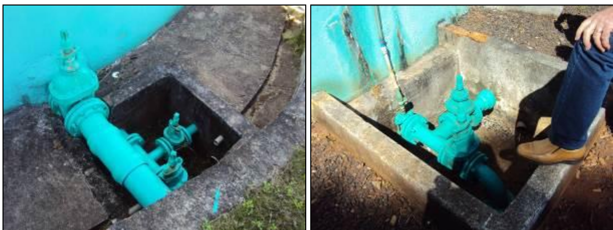
Figura 20: Outras imagens de estruturas do Sistema, sem gradeamento. (inicial)
