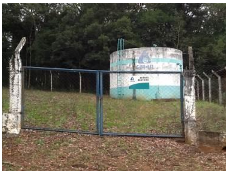
Figura 28: Portões e cercas do reservatório.
