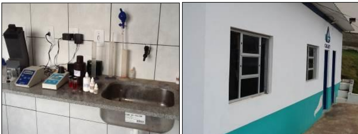
Figura 23: Nova casa de química da ETA e o Laboratório (acompanhamento)
