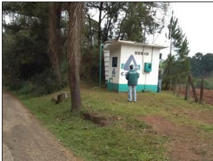
Figura 28: Estrutura componente da rede de distribuição (acompanhamento)
