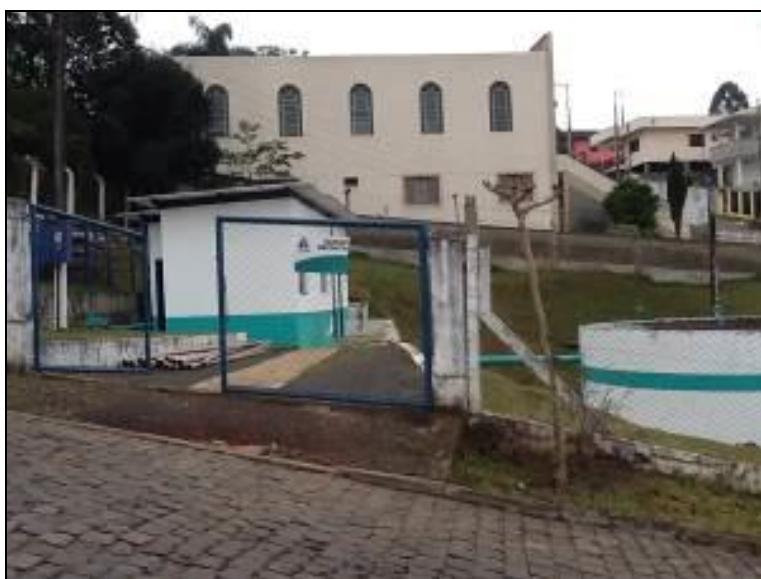
Figura 17: Vistas parciais da Estação de Tratamento de Tangará (acompanhamento)
