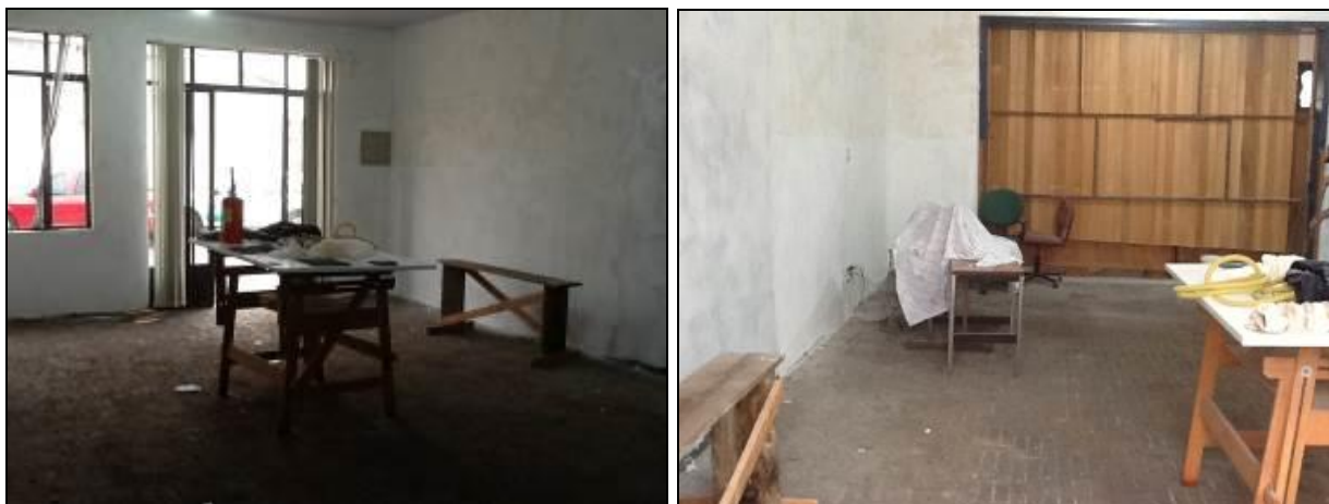
Figura 5 – Escritório/atendimento em reforma (acompanhamento)
