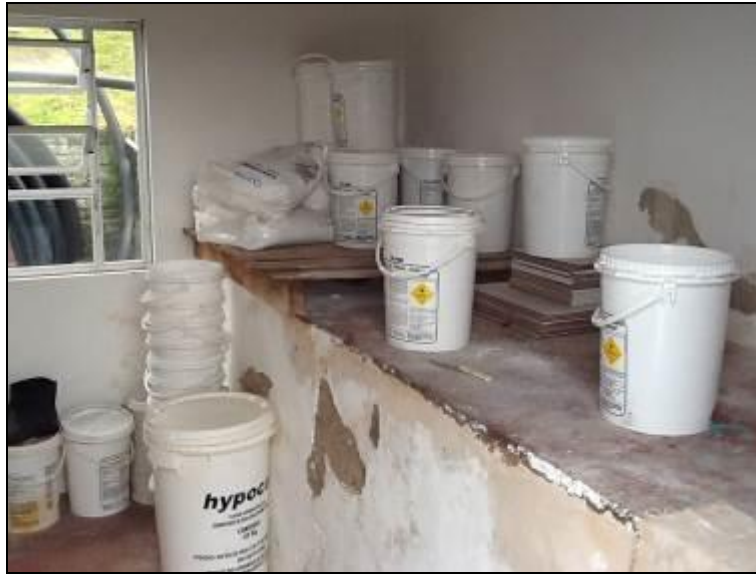
Figura 22: Depósito de produtos químicos
