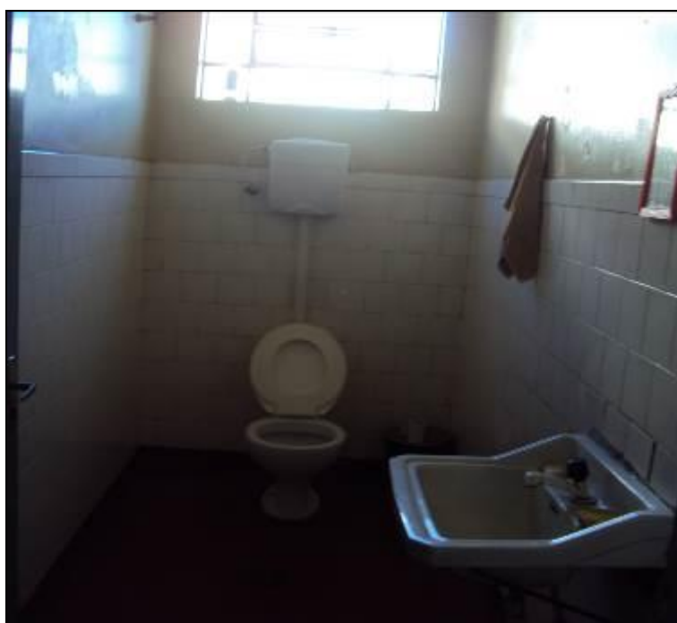
Figura 6 - Situação do Sanitário disponível. (inicial)
