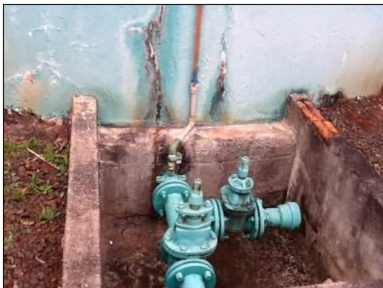
Figura 211 - Imagens de estruturas do sistema, sem gradeamento (acompanhamento)
