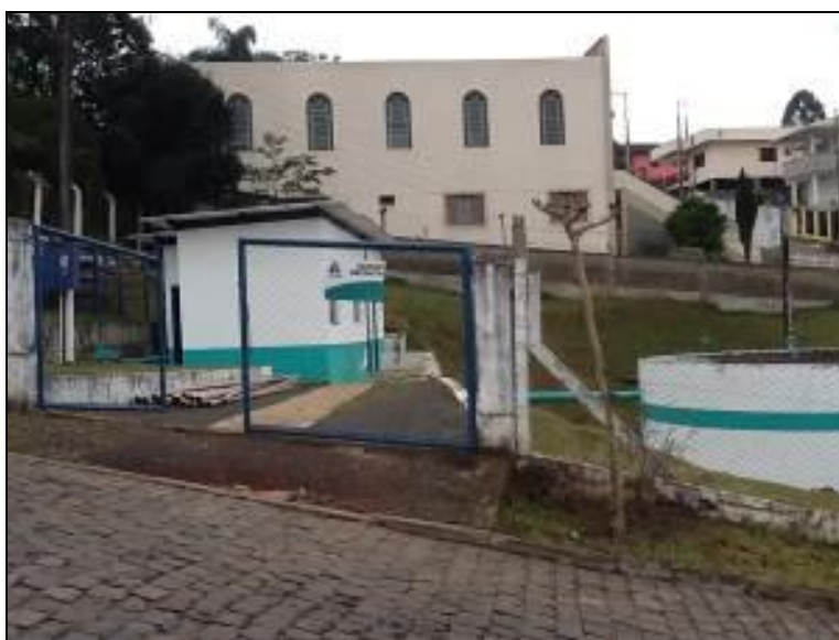
Figura 18: Vistas da Fachada da Estação de Tratamento (acompanhamento)
