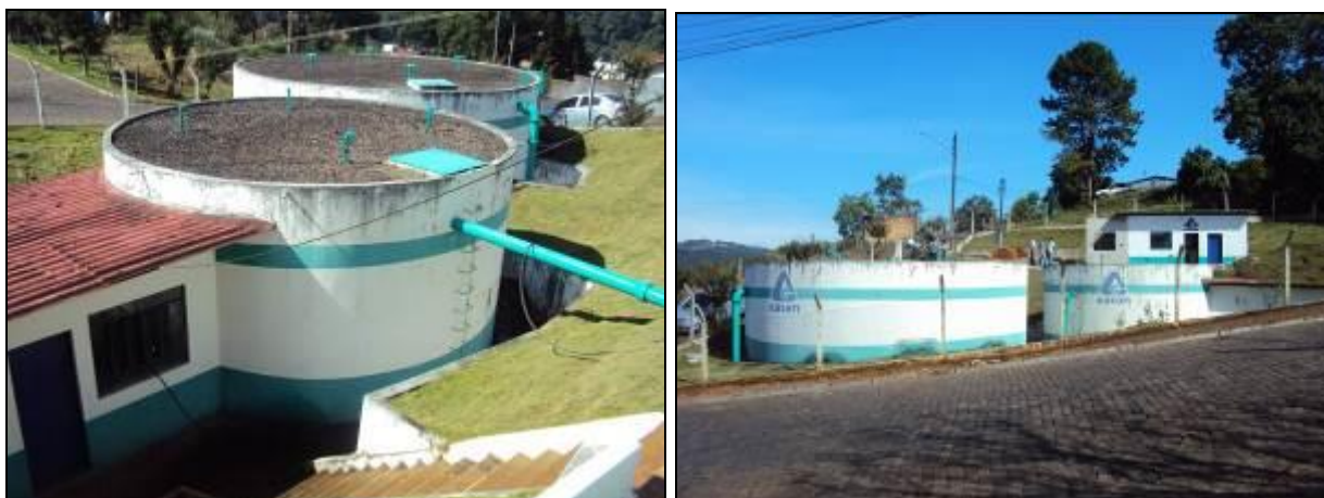
Figura 16: Vistas parciais da Estação de Tratamento de Tangará. (inicial)
