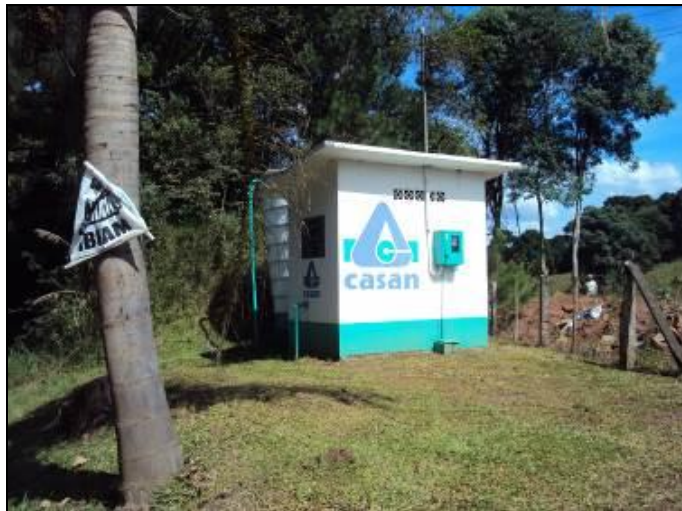
Figura 29: Estrutura componente da rede de distribuição (inicial)
