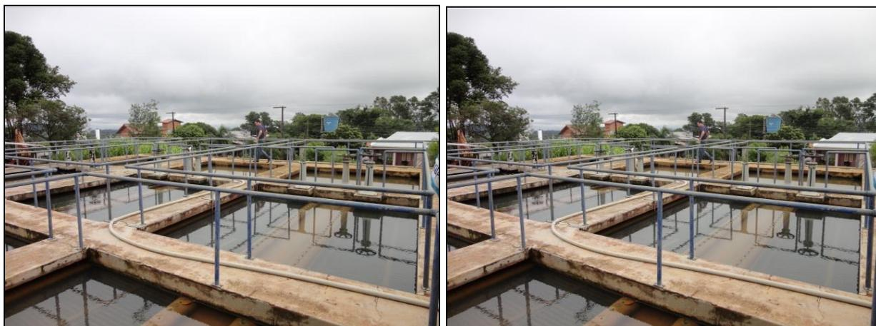
**Figura 24: Áreas de vistoria/manutenção dispõem de guarda-corpo**
