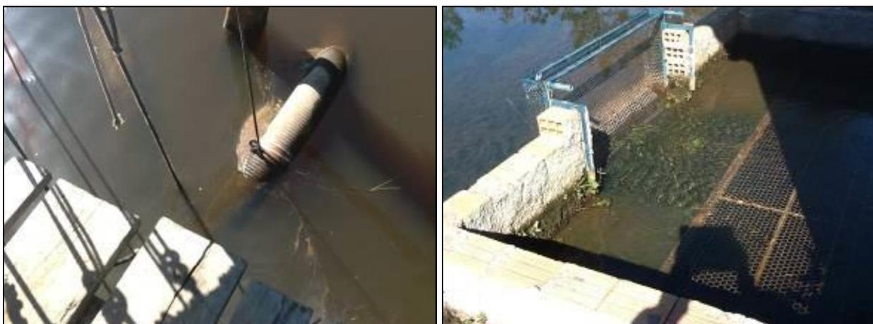
Figura 18: Área de sucção/entrada da água para as bombas de recalque. (Inicial)
