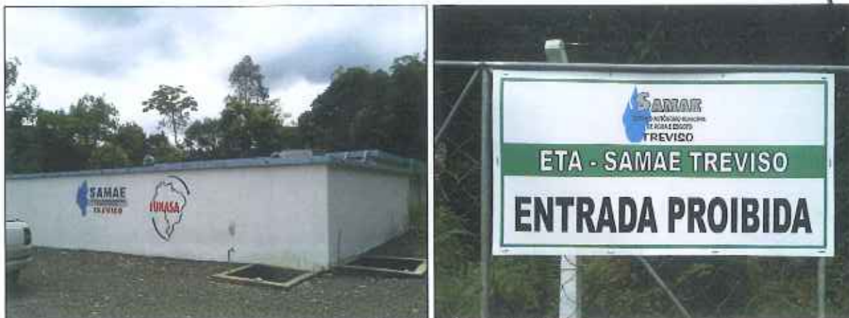
Figura 4: Reservatório da ETA
