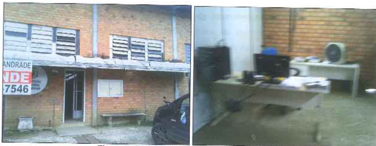
Figura 1: Fachada do Escritório SAMAE Treviso
