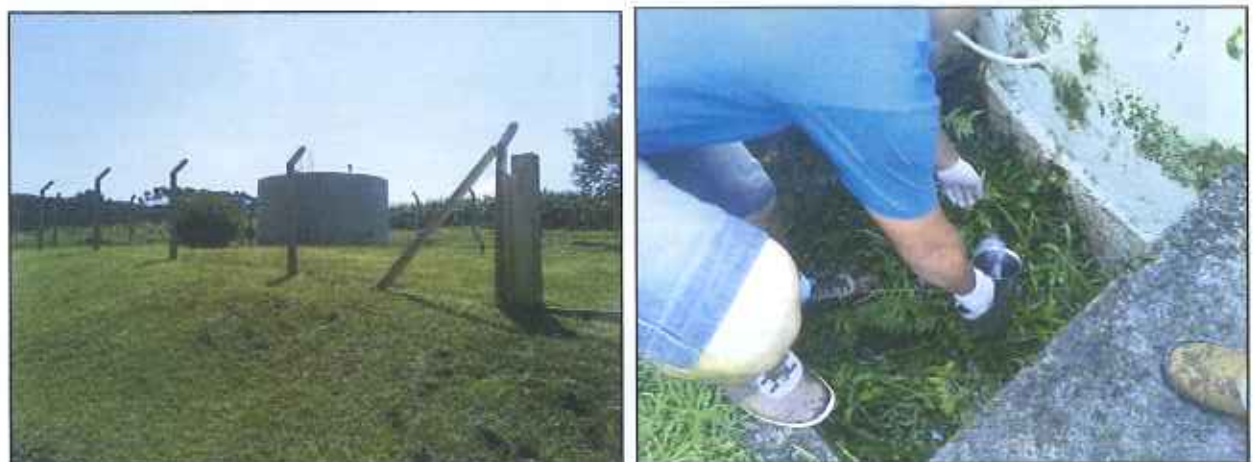
Figura 7: Coleta de amostra de água no Reservatório Vila Cedro
