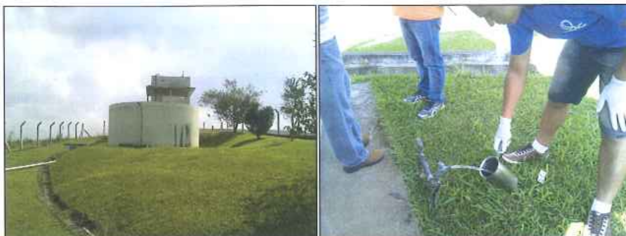
Figura 3: Coleta de amostra de água na ETA Fragoso
