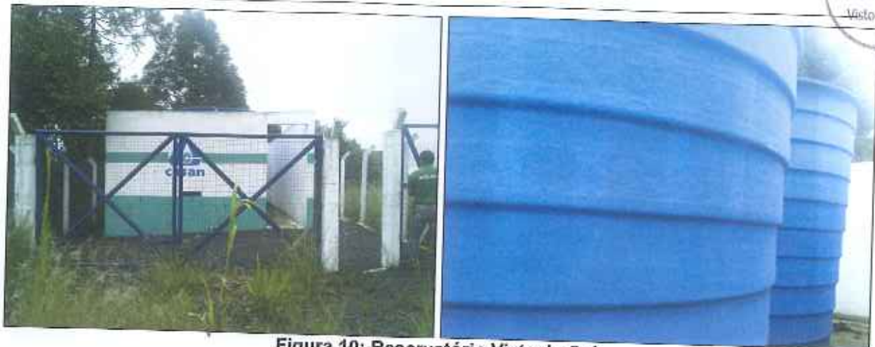
Figura 10: Reservatório Vista do Sol
