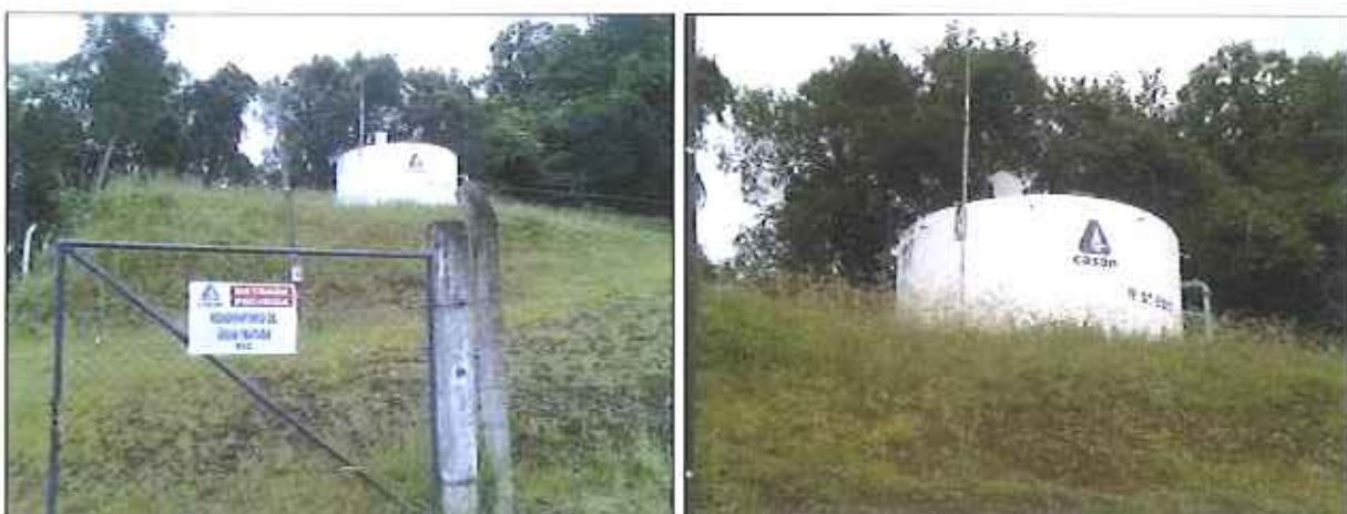
Figura 26: Reservatório R05.1 – 50 m 3
