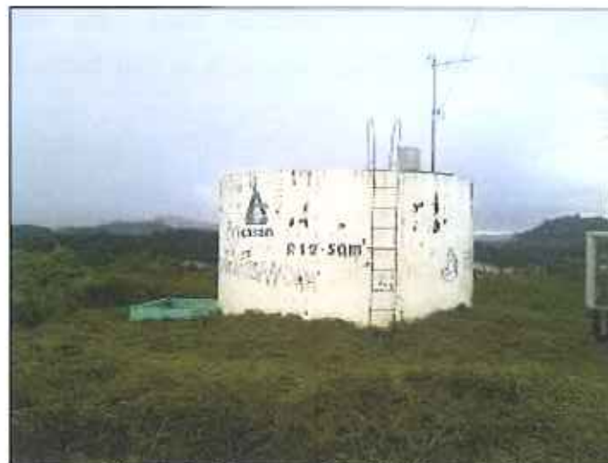
Figura 9: Reservatório R01.2 – 50 m 3
