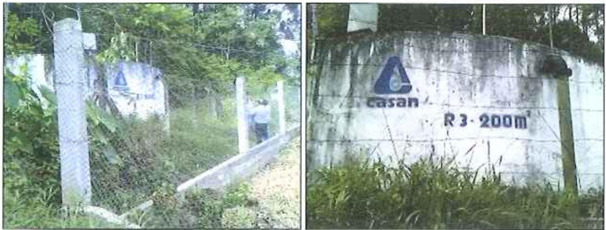
Figura 19: Reservatório R03 – 200 m 3
