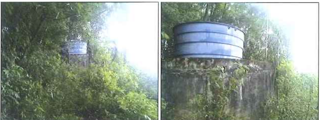
Figura 21: Reservatório R03.2 – 25 m 3
