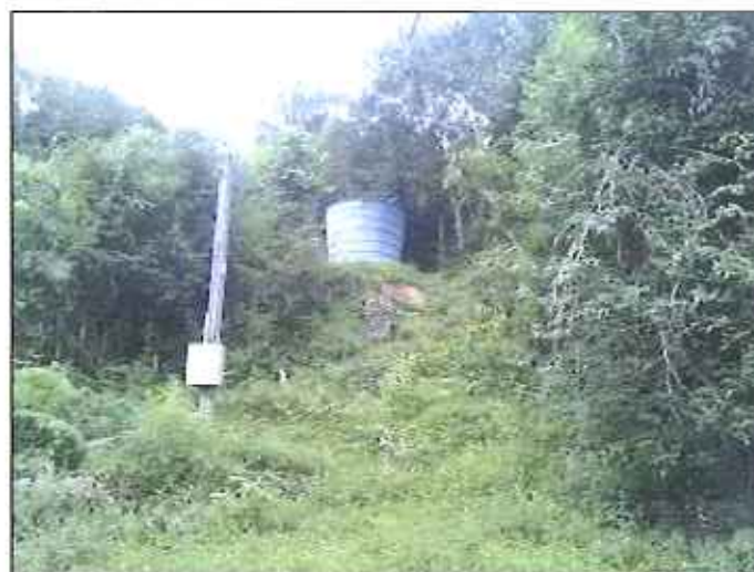
Figura 11: Reservatório R01.4 – 20 m³
