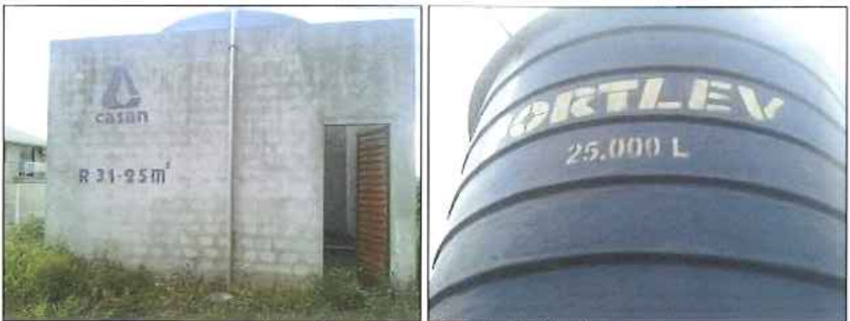
Figura 20: Reservatório R03.1 – 25 m 3
