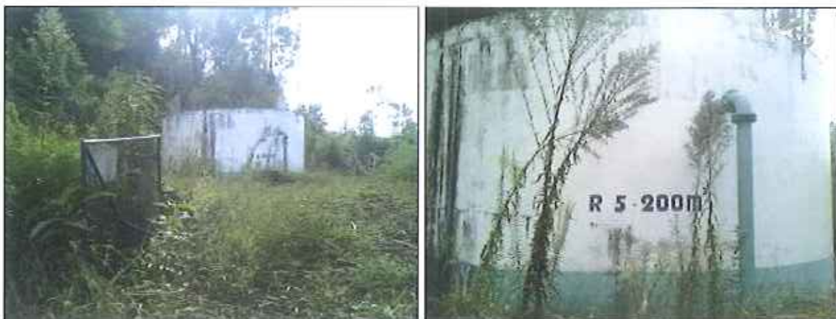
Figura 25: Reservatório R05 – 200 m 3
