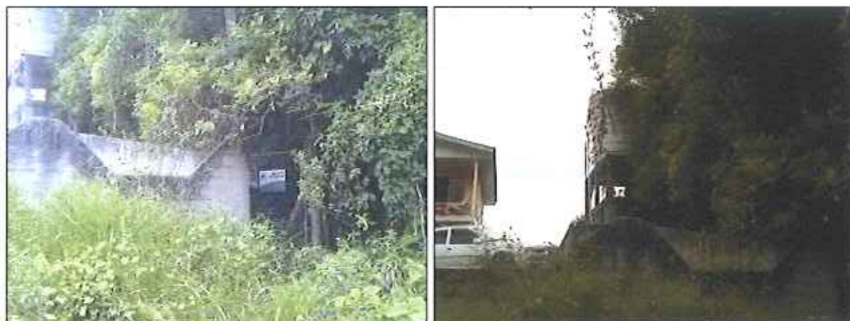
Figura 12: Reservatório R01.5 – 20 m³
