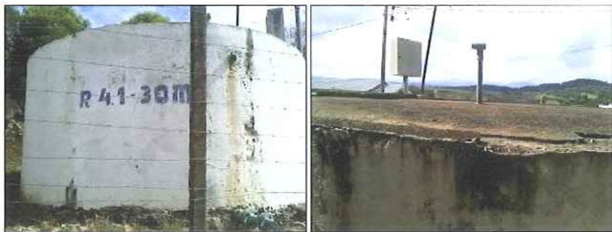
Figura 23: Reservatório R04.1 – 30 m³
