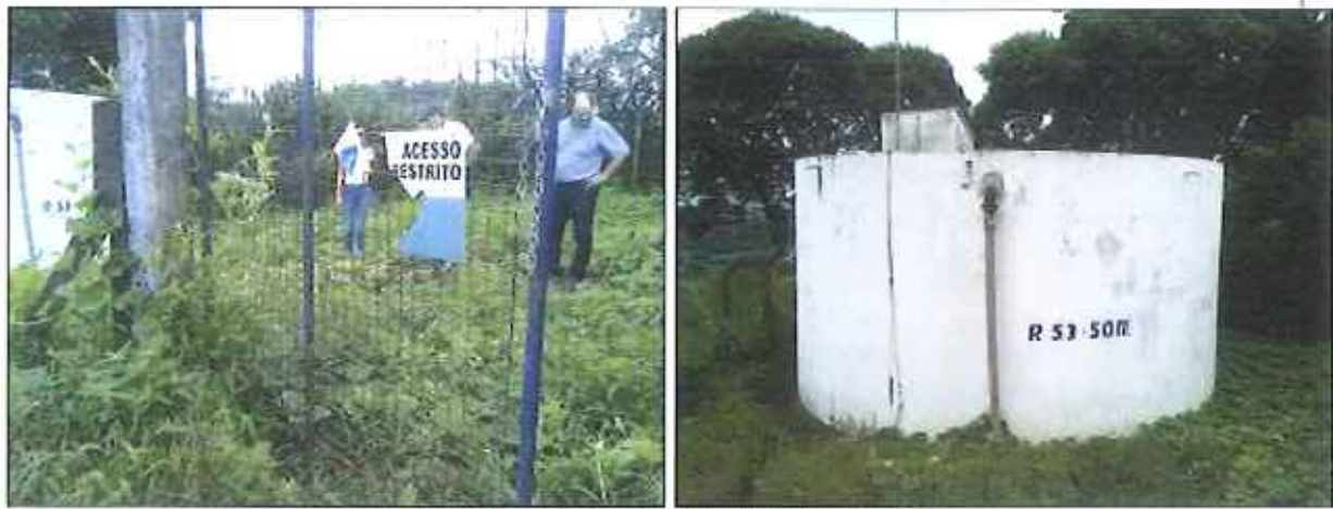
Figura 28: Reservatório R05.3 – 50 m 3
