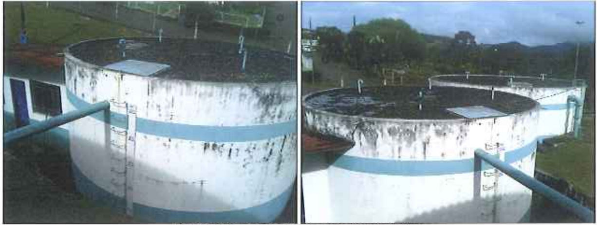
Figura 13: Reservatório R01, junto à ETA
