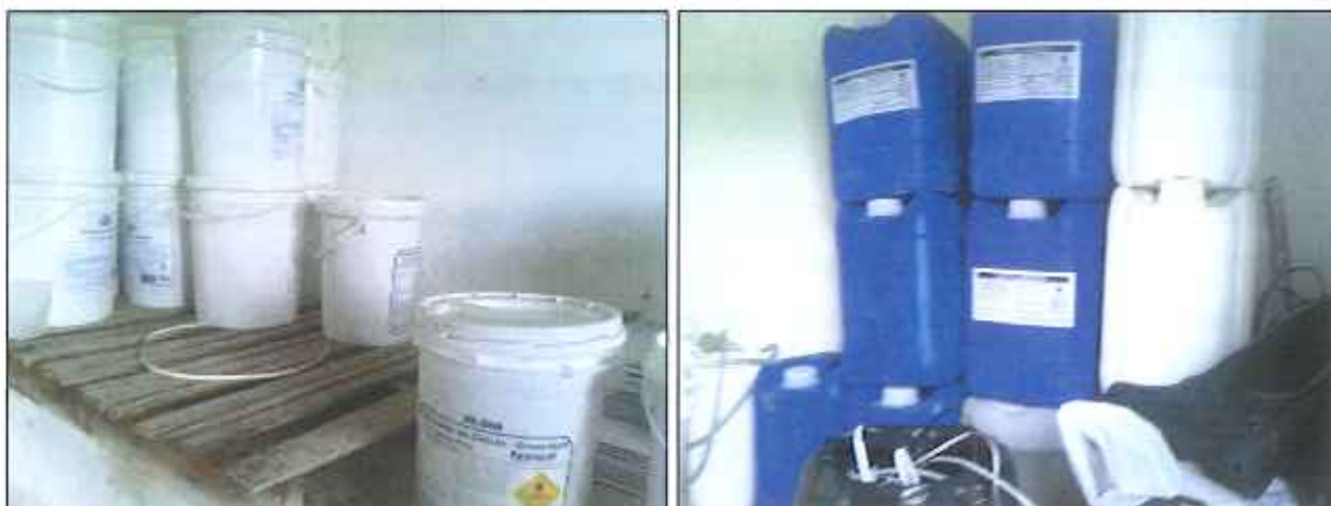
Figura 11: Armazenamento de produtos químicos inadequado
