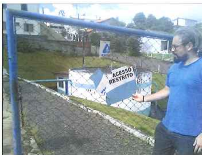
Figura 8: Placa de restrição de acesso quebrada
