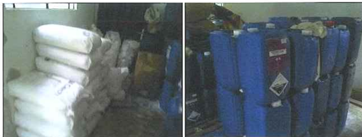
Figura 8: Produtos químicos da ETA
