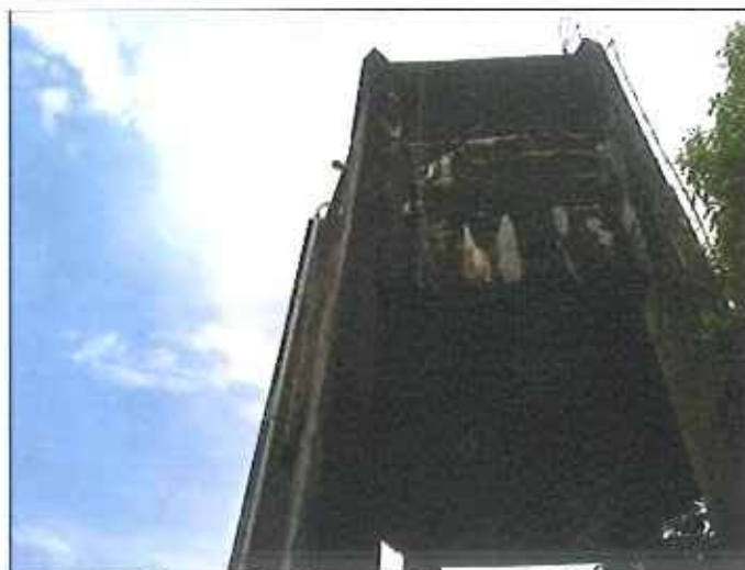
Figura 12: Escada do reservatório
