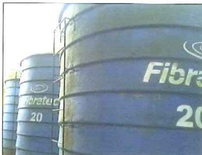
Figura 10: Escada do Reservatório
