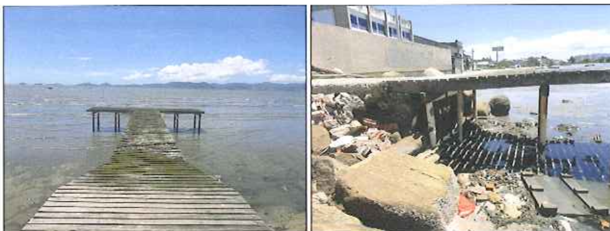
Figura 3: Trapiche sobre a tubulação do extravasor e local de saída do extravasor (17/02/2016)
