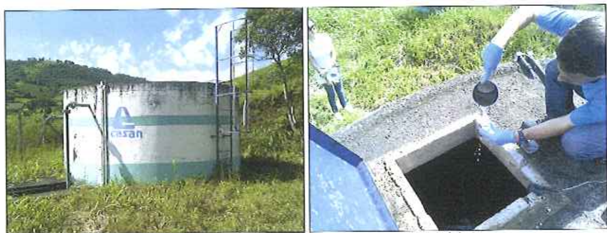
Figura 2: Coleta de amostra de água no reservatório
