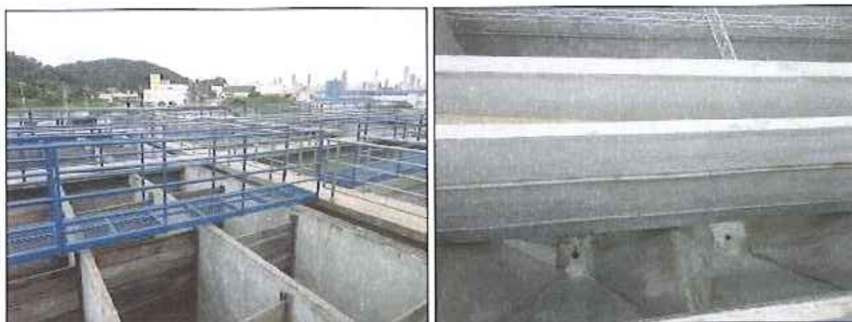
Figura 3: Novo floculador (à esquerda) e novo decantador (à direita)
