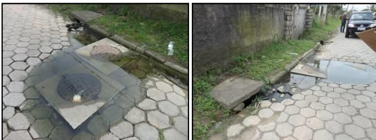
Figura 2: Vazamento de efluente de um PV
