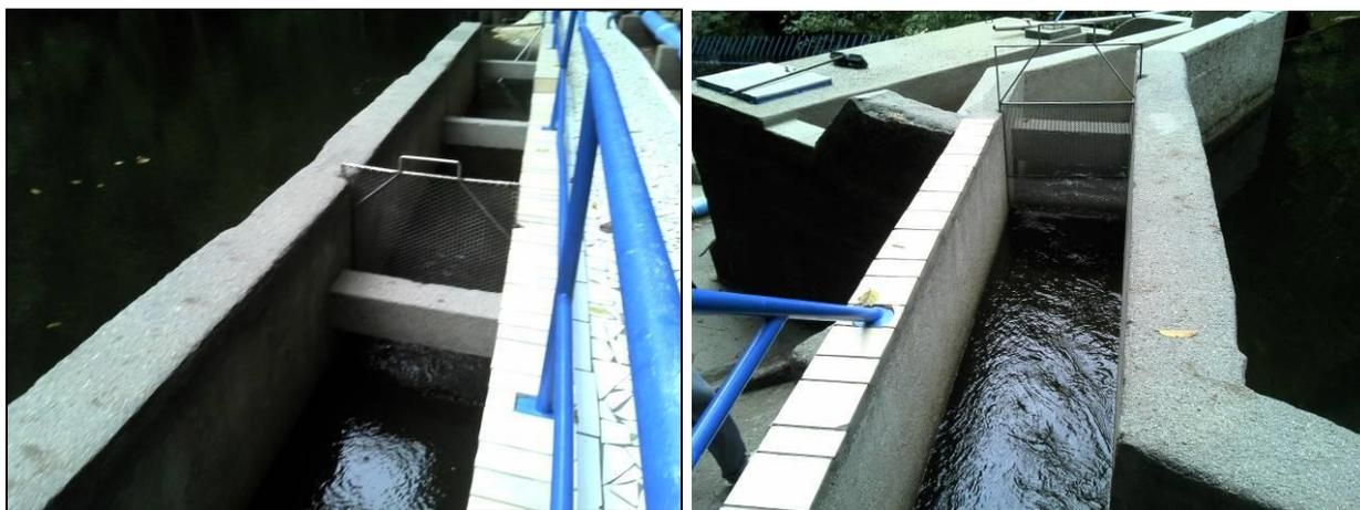
Figura 11: Sistema de pré – filtragem e canaletas para captação de água bruta
