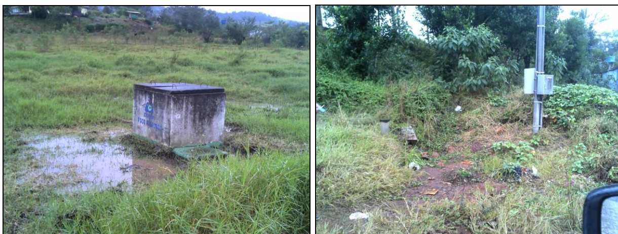
Figura 1: Poço 1 em operação (à esquerda) e Poço 2 novo (à direita) (GEFIS 043/2015)
