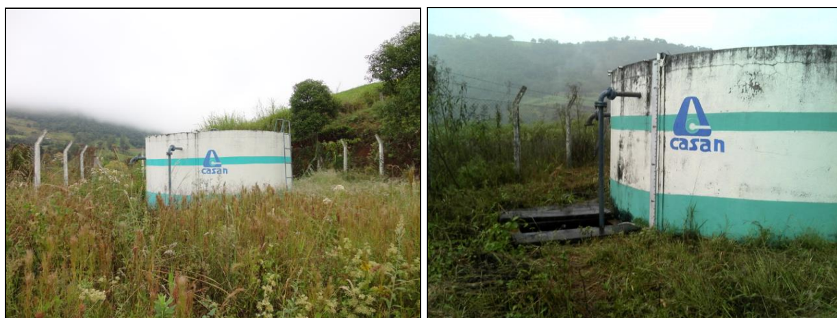
Figura 4: Reservatório com medição de nível (GEFIS 091/2013 à esquerda e GEFIS 042/2015 à direita)
