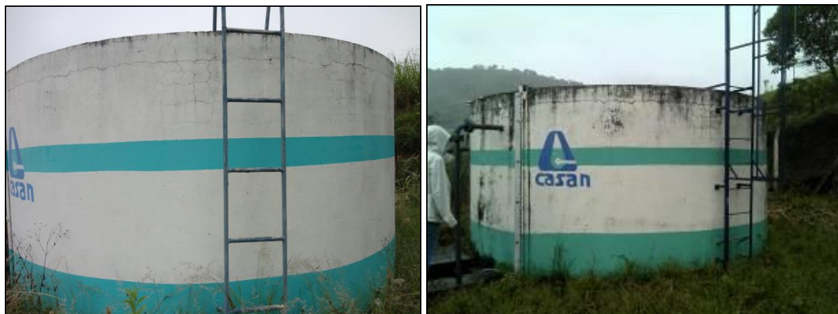
Figura 3: Reservatório com guarda-corpo na escada (GEFIS 091/2013 à esquerda e GEFIS 042/2015 à direita)
