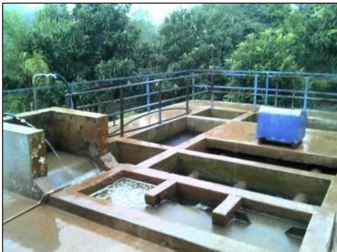
**Figura 6:** Filtros e decantadores sem tampas (GEFIS 041/2015)
