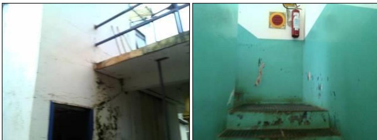
**Figura 11: ETA com rachaduras e infiltrações (GEFIS 038/2015)**
