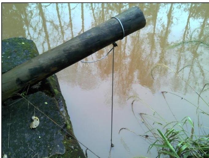
**Figura 12: Poço de sucção de água bruta em local inadequado (GEFIS 038/2015)**
