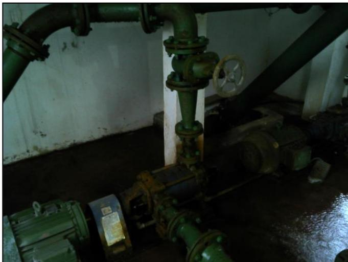
Figura 4: ERAB com vazamentos (GEFIS 041/2015)
