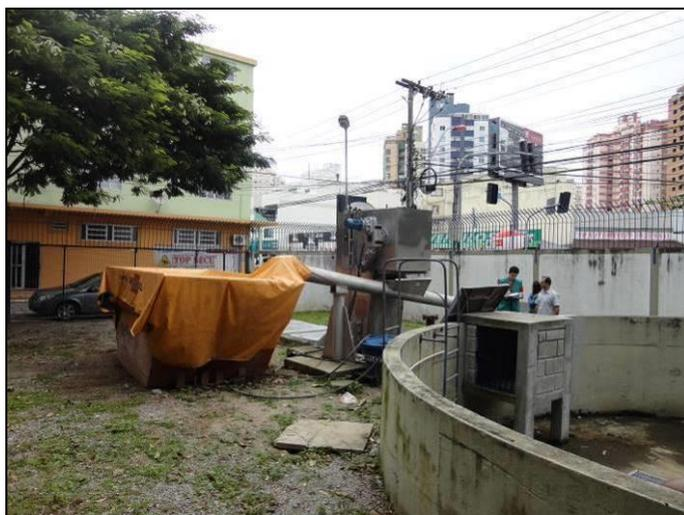
Figura 64: Gradeamento e contêiner de armazenamento
