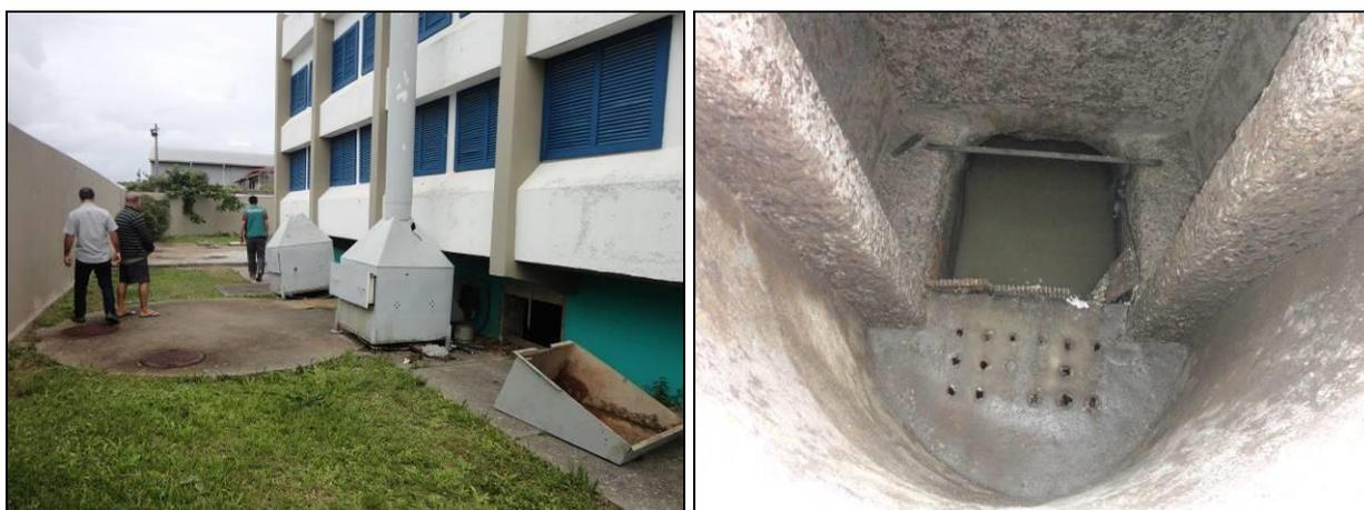
**Figura 68: Vista externa e interna do poço úmido**
