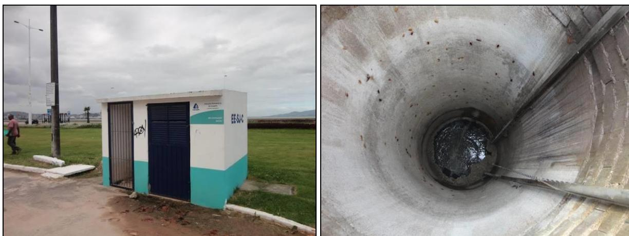
Figura 54: Vista externa e interna do poço úmido
