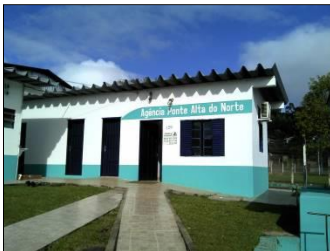
Figura 1: Agência de Ponte Alta do Norte
