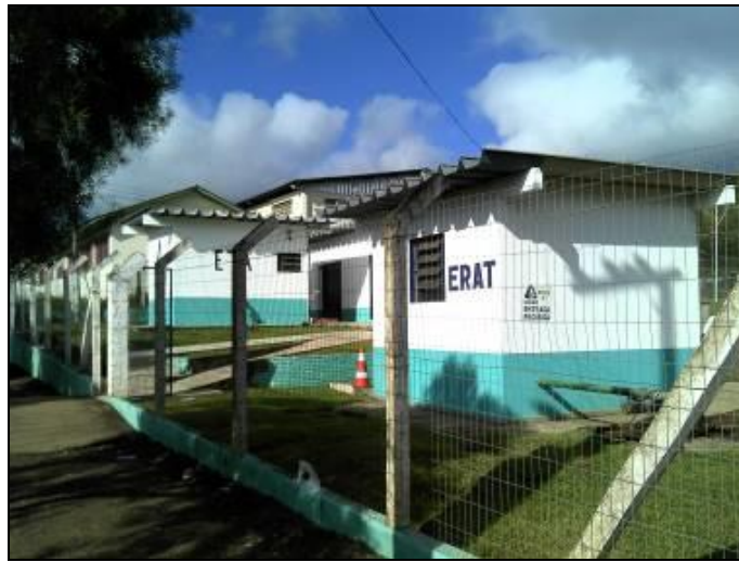
Figura 13: Entorno da ETA
