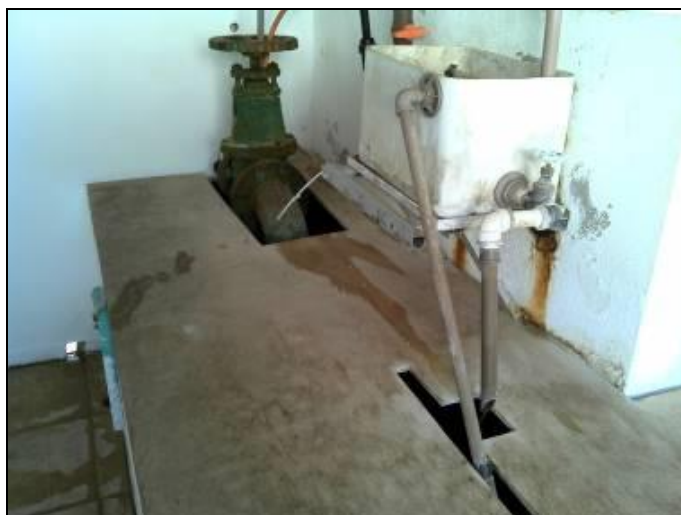
Figura 14: Casa de Química da ETA
