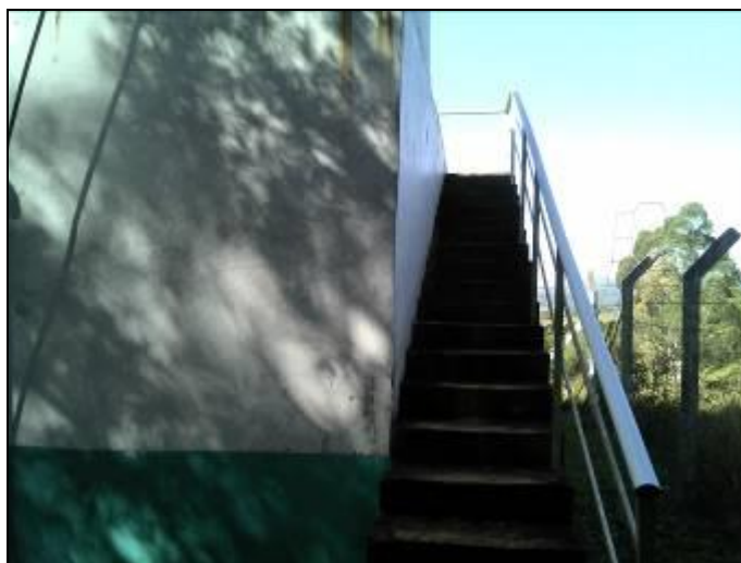
Figura 11: Escada de acesso a ETA
