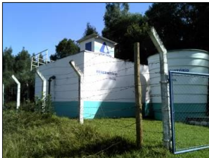
Figura 9: Vista da ETA
