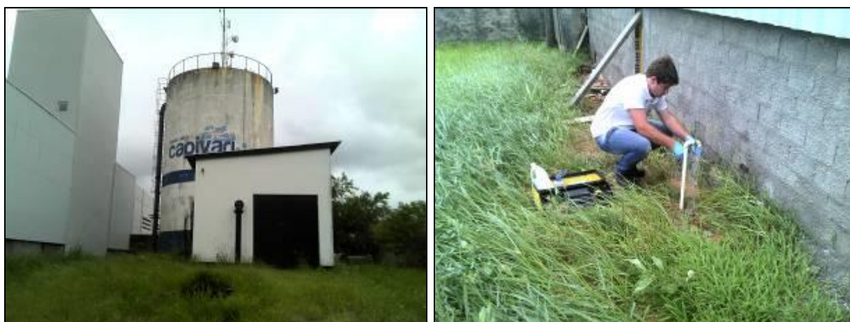
Figura 1: Coleta de amostra de água no Reservatório 1
