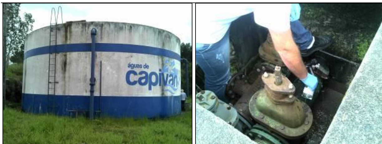
Figura 2: Coleta de amostra de água no Reservatório 2
