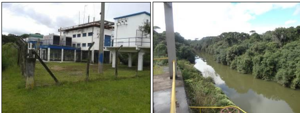
Figura 1: Área do manancial de captação de água bruta Rio Caveiras
