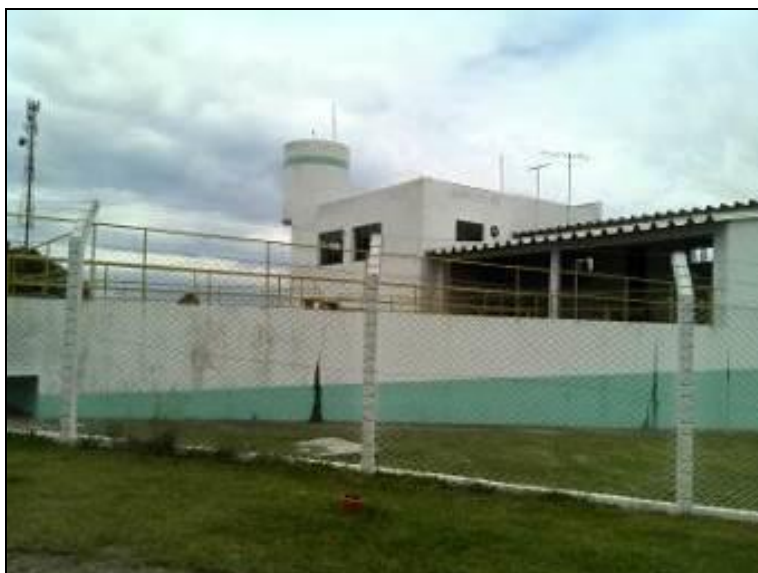
Figura 12: Estrutura física da ETA
