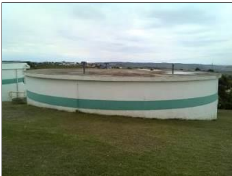
Figura 23: Entorno dos Reservatórios
