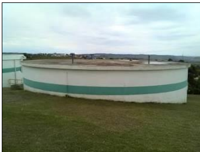
Figura 25: Cobertura dos Reservatórios
