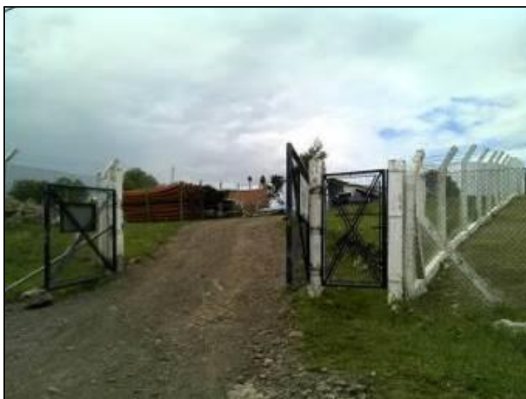
Figura 15: ETA com proteção de cercas.
