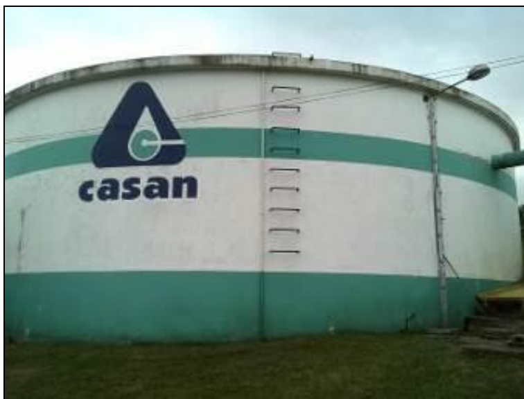
Figura 24: Escada do Reservatório
