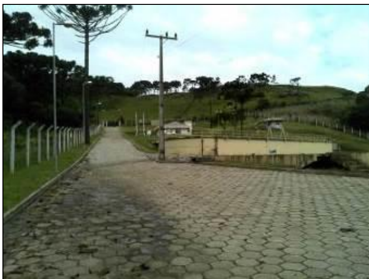
Figura 40: Acesso à ETE
