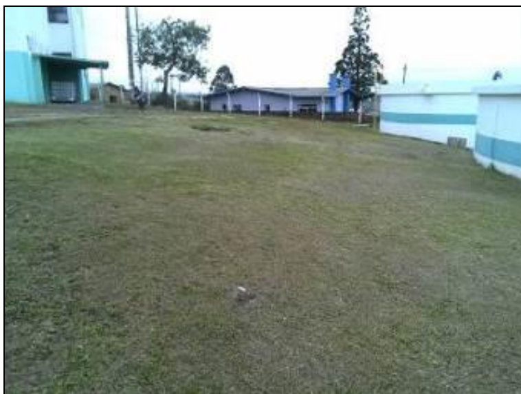
Figura 16: Condições do pátio da ETA
