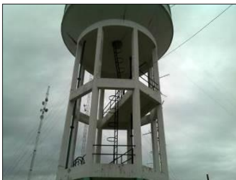
Figura 28: Escadas do Reservatório
