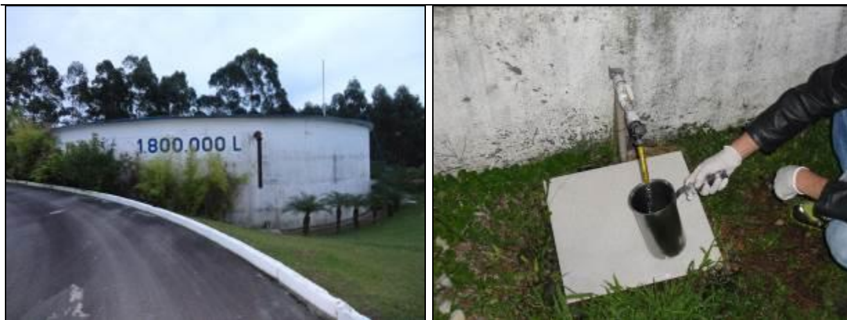
Figura 6: Coleta de água no Reservatório da ETA Itinga de 1.800.000 litros (10/06/2014)
