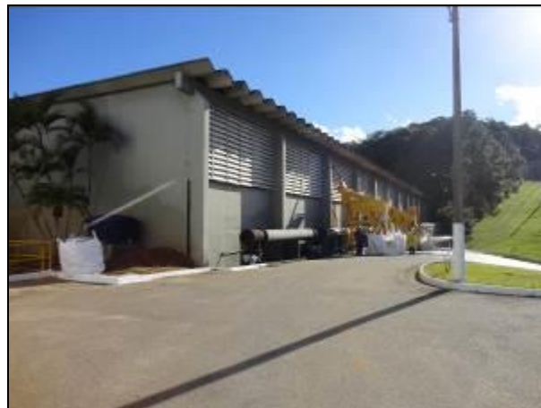
Figura 5: Reforma nos filtros (30/05/2014)
