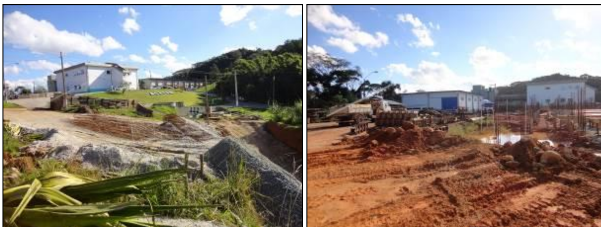
Figura 1: Situação das obras na ETA Morro dos Quadros (30/05/2014)
