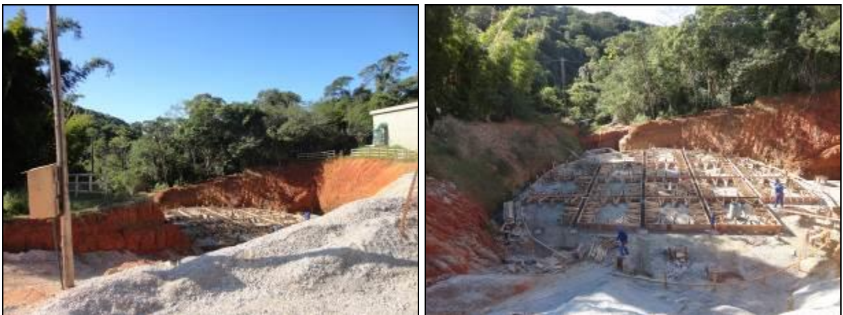
Figura 4: Obras do Tanque de Equalização (30/05/2014)
