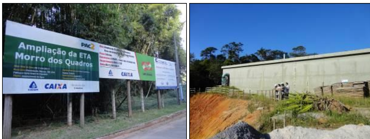
Figura 2: Situação das obras na ETA Morro dos Quadros (30/05/2014)
