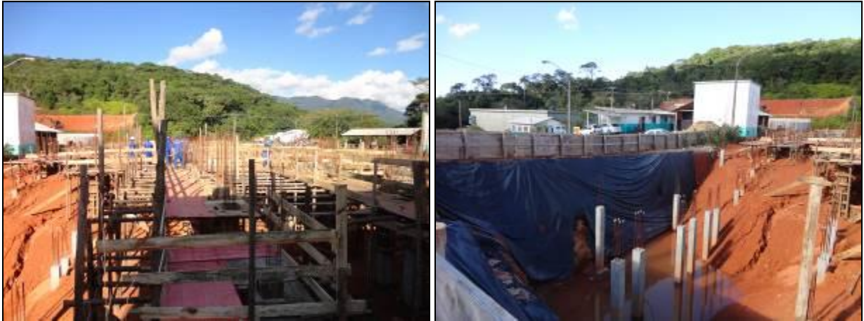
Figura 3: Obras do floccodecantador (30/05/2014)
