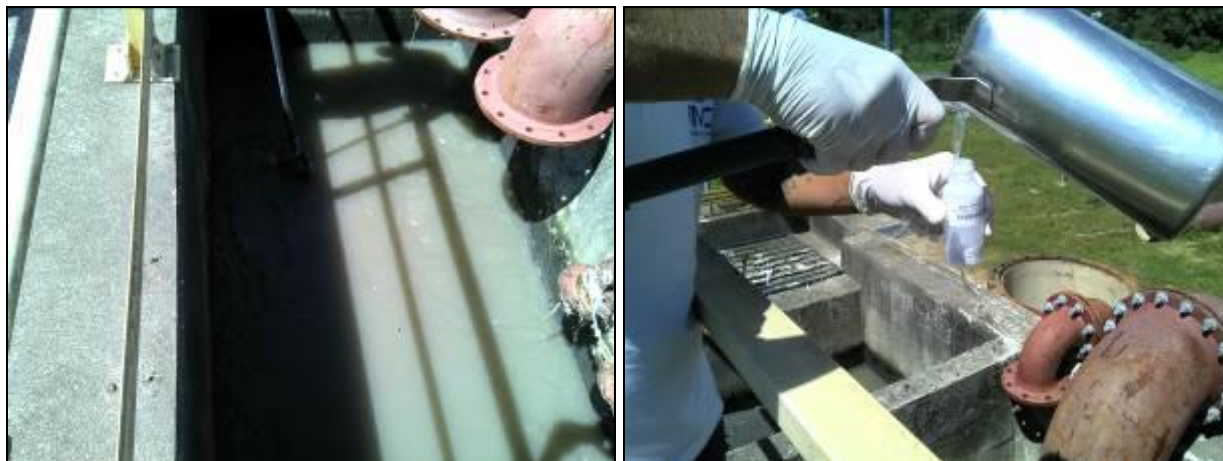
Figura 15: Coleta do efluente bruto da ETE (28/02/2014)
