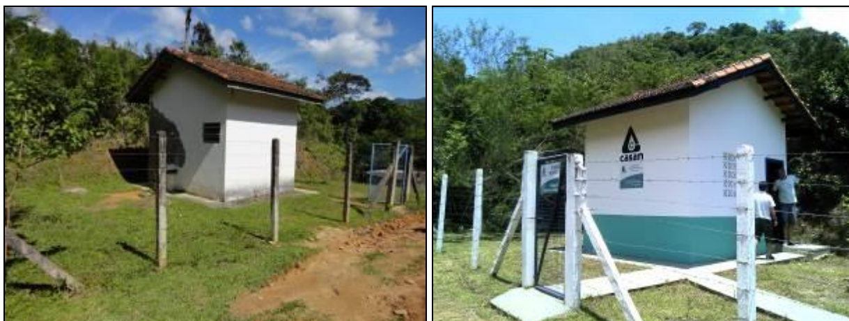
Figura 9: Fachada da ETA (inicial e acompanhamento)
