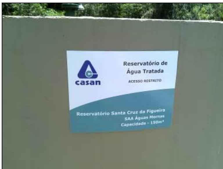
Figura 15: Identificação no Reservatório (acompanhamento)
