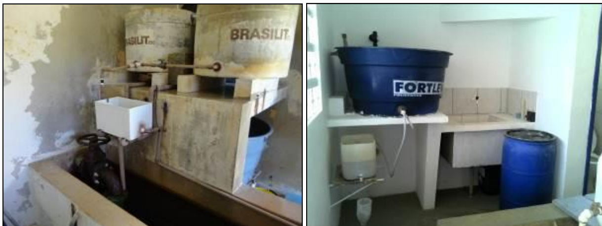
Figura 11: Laboratório da ETA (inicial e acompanhamento)
