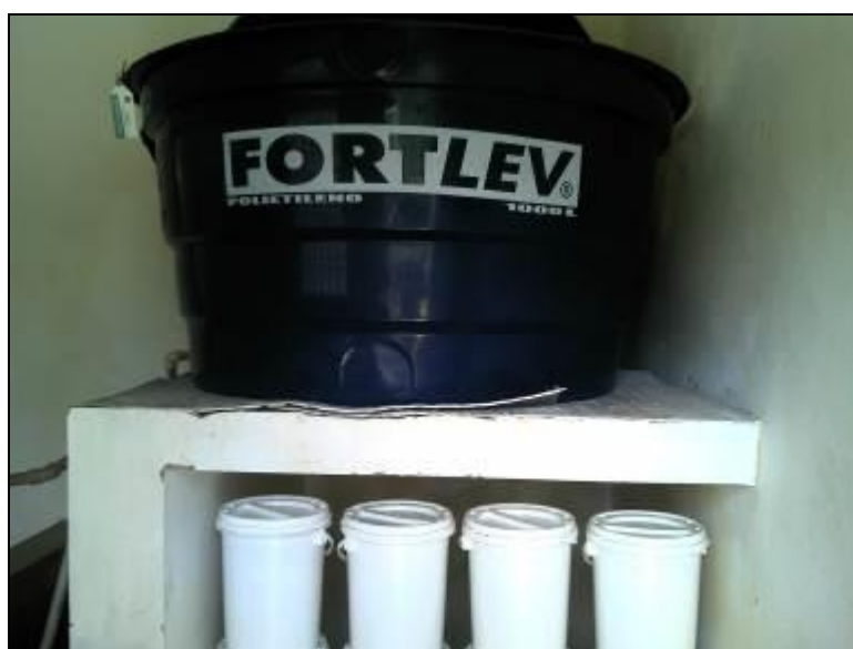
Figura 13: Guarda dos produtos químicos
