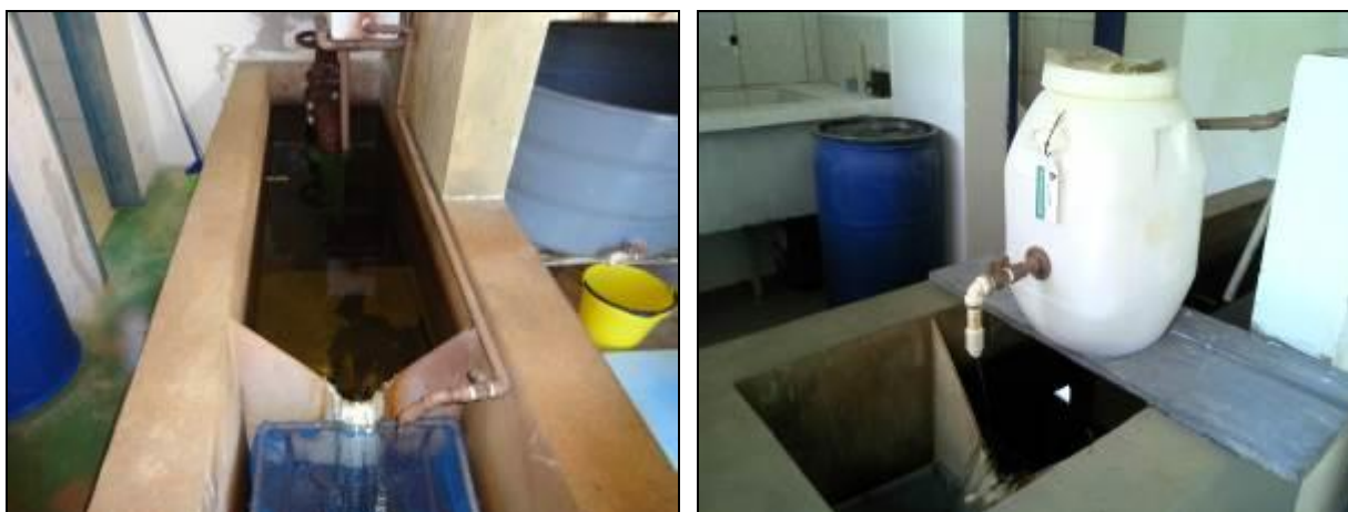
Figura 12: Estrutura da casa de química (inicial e acompanhamento)
