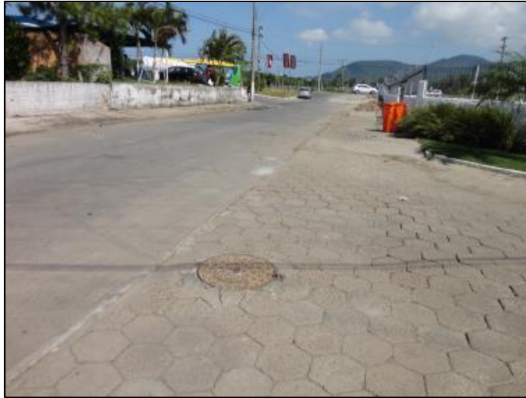
Figura 4: Poço de visita em frente à ACM
