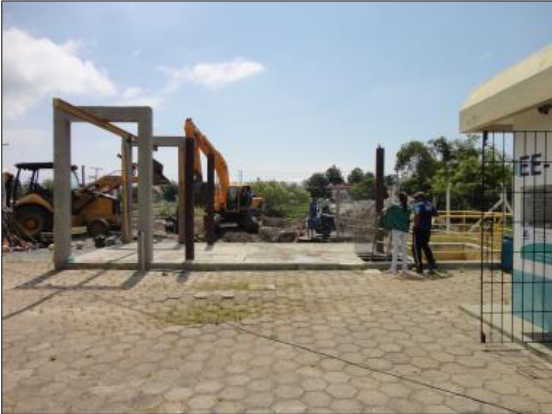
Figura 2: Obras na EEE B01 Cachoeira
