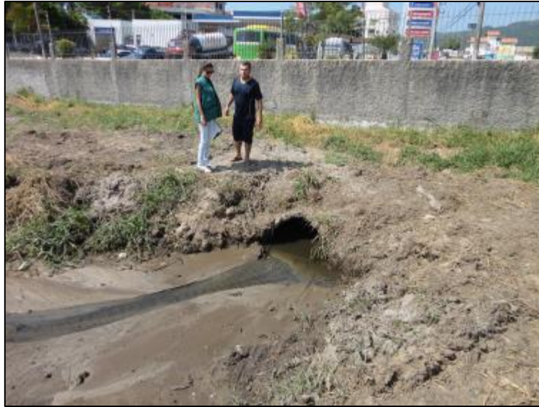
Figura 6: Área da AMC onde deságua a rede pluvial
