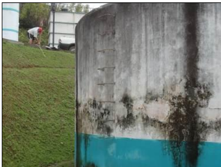
Figura 23: Escada de acesso
