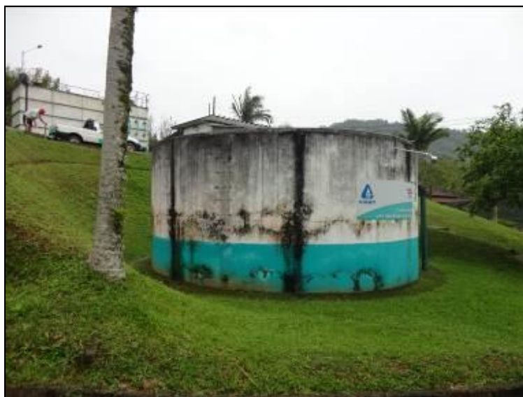
Figura 22: Vista do entorno do reservatório
