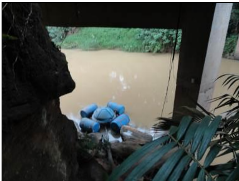
Figura 10: Condições Operacionais da Captação.
