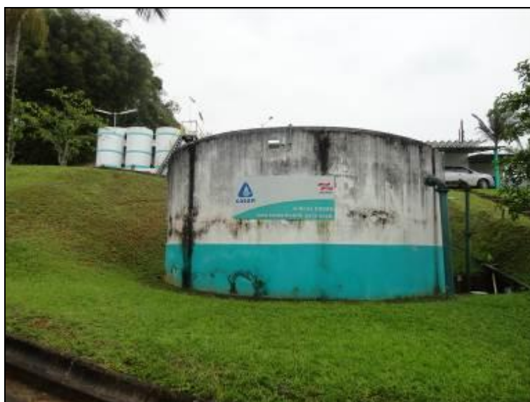
Figura 20: Reservatório junto a ETA
