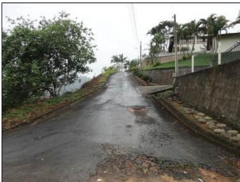
Figura 12: Acesso a ETA
