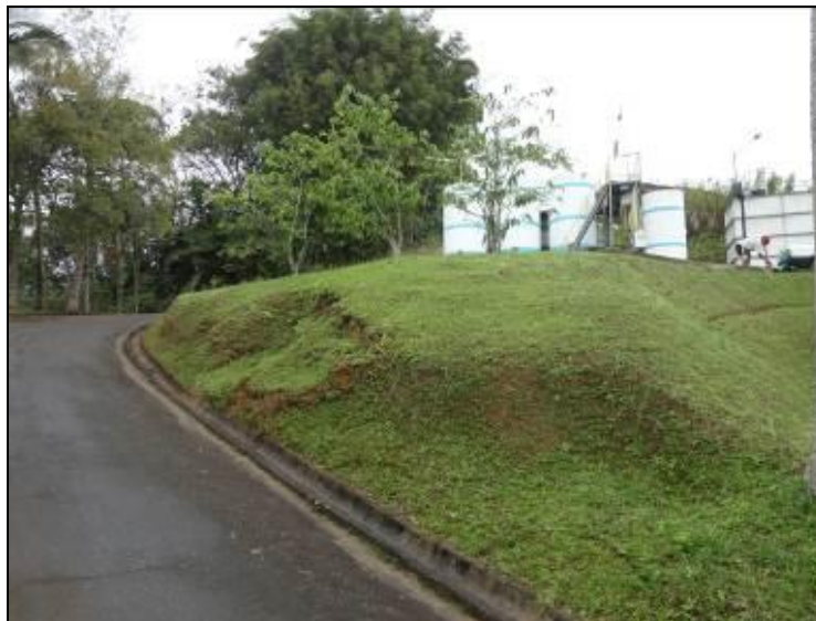
Figura 14: Acesso entorno da ETA
