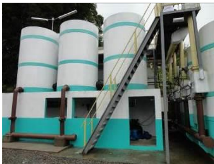
Figura 15: Escada de Acesso a ETA
