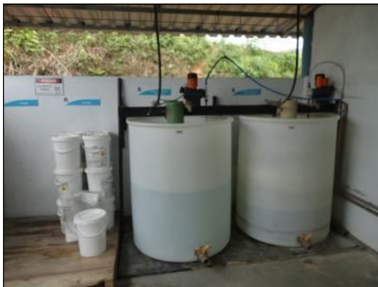
Figura 18: Casa de Química
