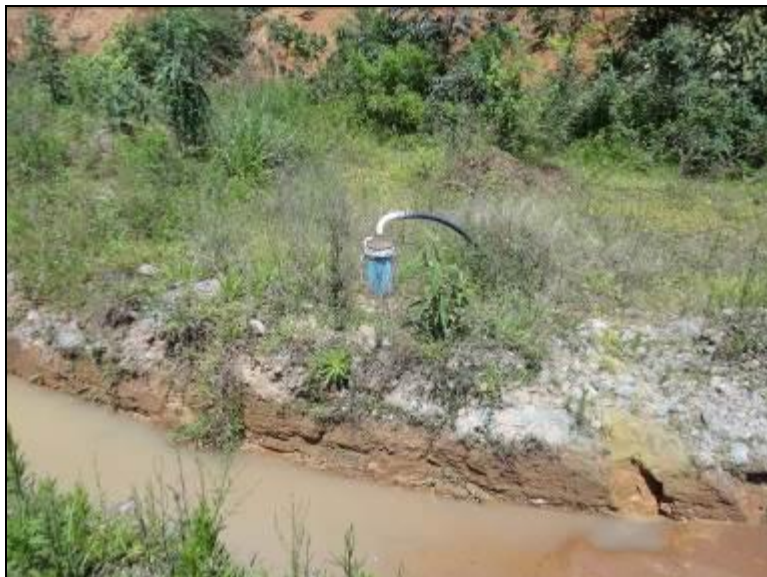
Figura 3: Acesso ao Poço
