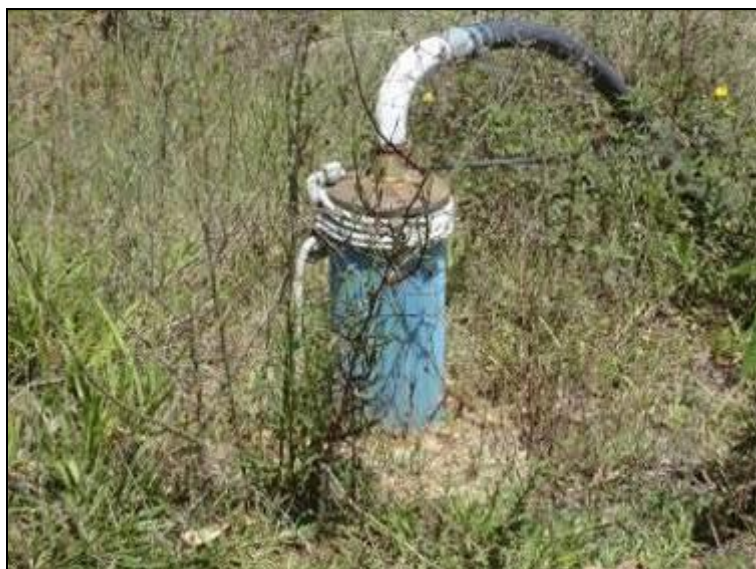
Figura 2: Vista do Poço
