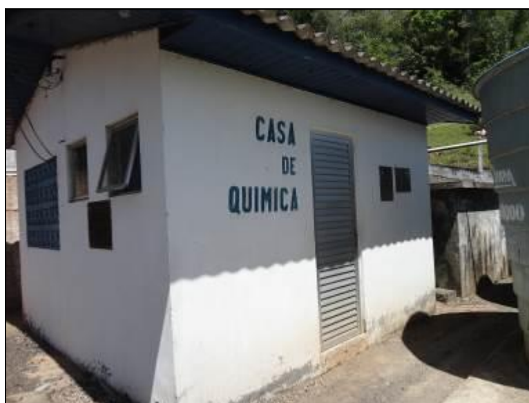
Figura 5: Vista da casa de química da ETA
