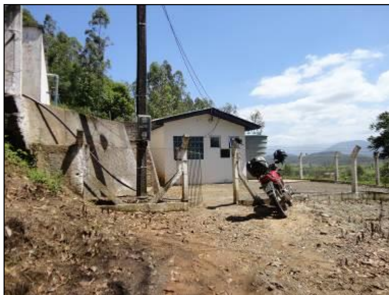
Figura 4: Fachada da ETA
