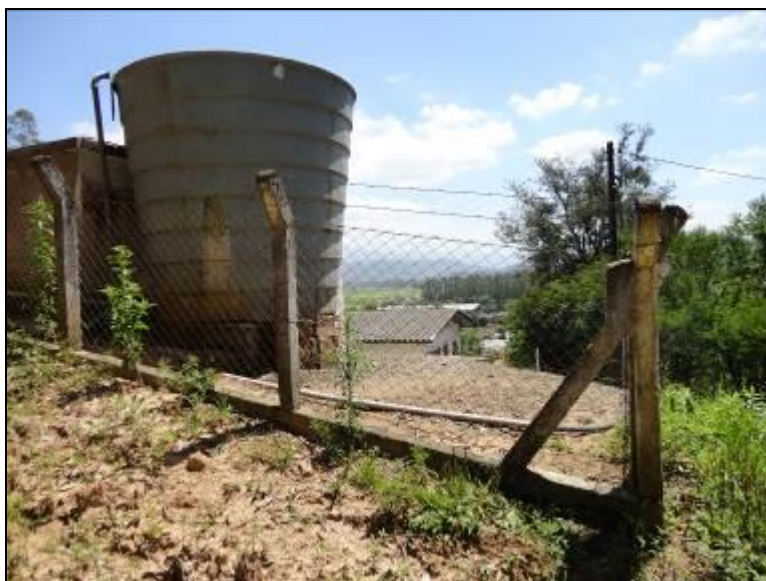
Figura 10: Vista do Reservatório
