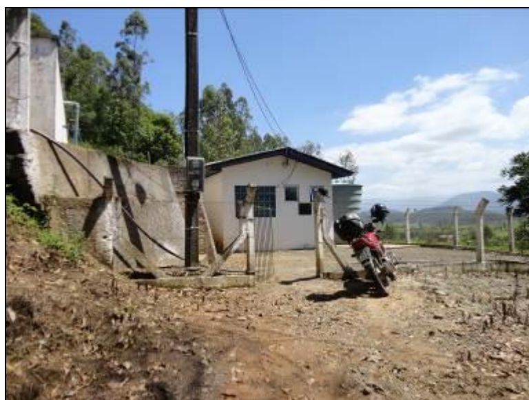
Figura 7: Cercas de entorno da ETA
