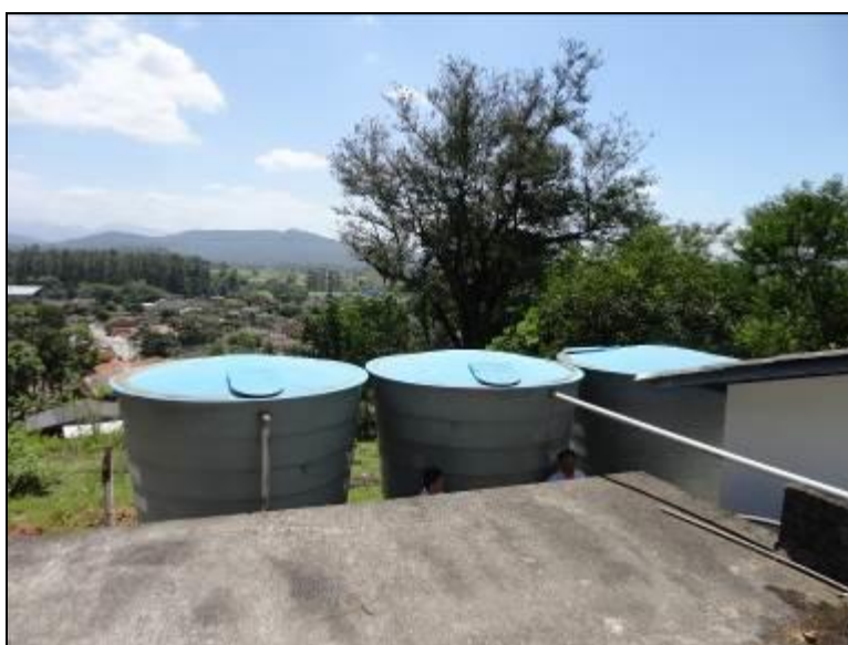
Figura 13: Cobertura do Reservatório
