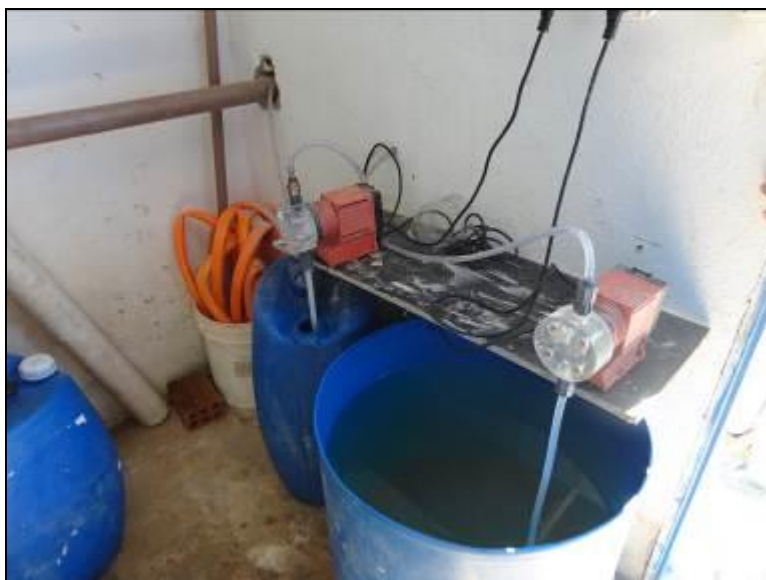
Figura 16: Estrutura da casa de química (acompanhamento)
