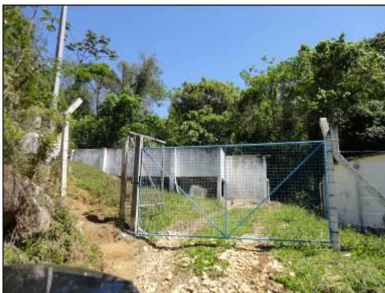
Figura 13: Cerca de proteção ETA (acompanhamento)
