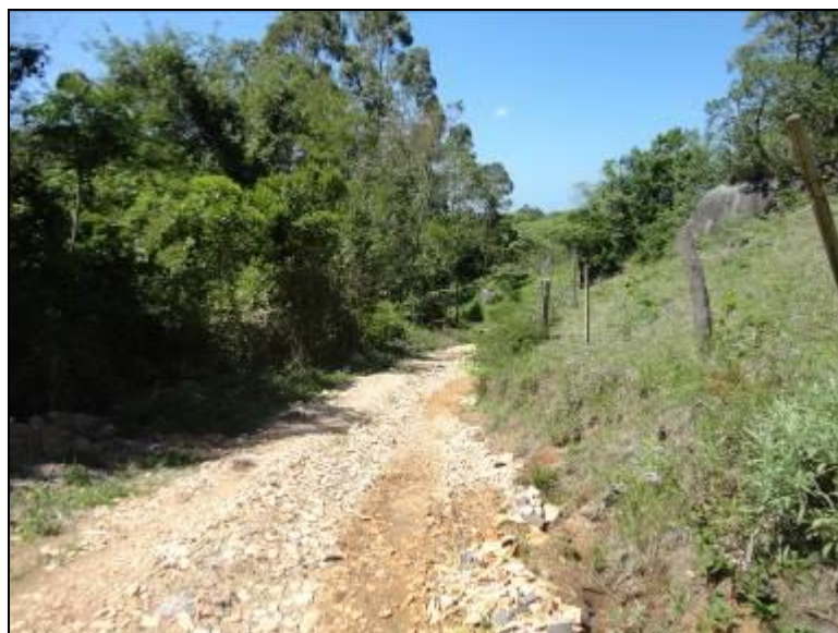
Figura 12: Acesso a ETA (acompanhamento)
