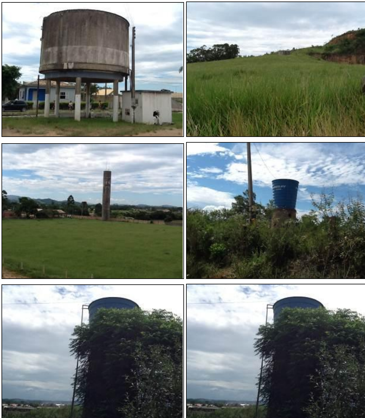
Figura 18: Reservatórios disponíveis no SAA de Sangão (inicial)
