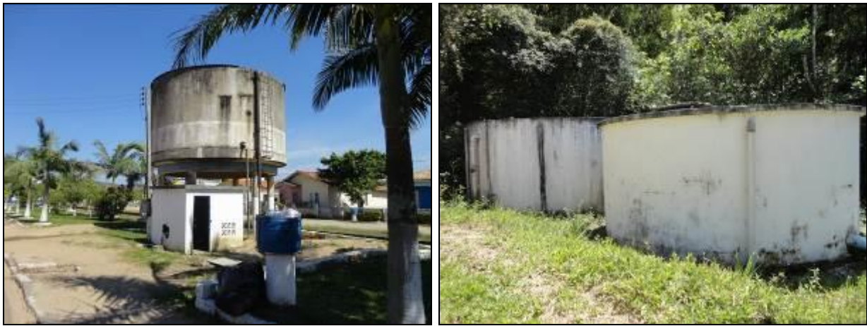
Figura 19: Reservatórios Sangão (acompanhamento)
