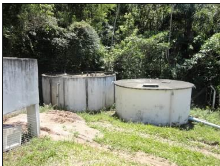
Figura 20: Cobertura do Reservatório (acompanhamento)
