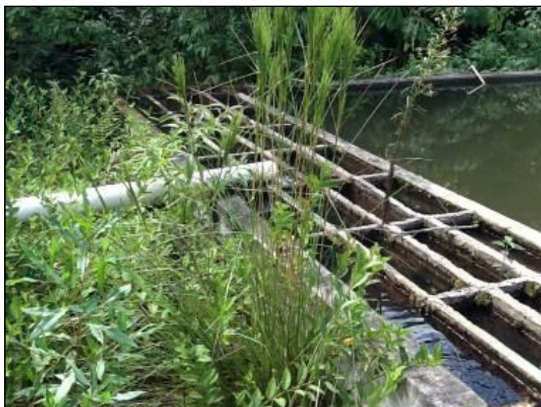
Figura 11: Entorno da ETA (inicial)
