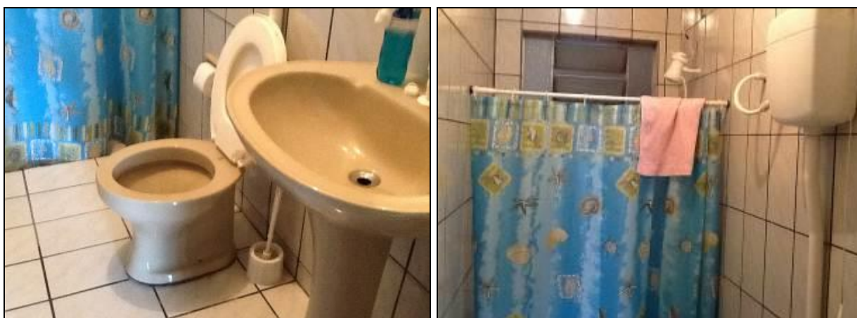
Figura 6: Sanitário da Unidade (Inicial)
