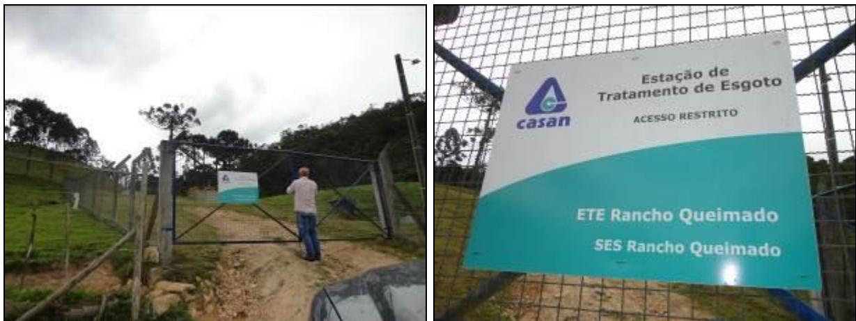
Figura 42: Vista geral da área da ETE e placa de identificação (Acompanhamento)
