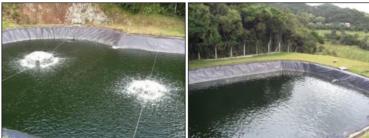
Figura 48: Lagoas de aerção e decantação (Inicial)
