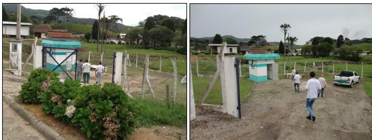
Figura 23: Acesso a Casa de Química de Taquaras (Inicial à esquerda – Acompanhamento à direita)
