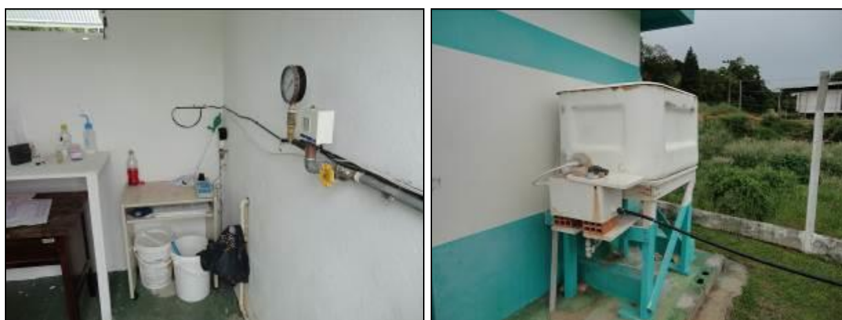
Figura 25: Casa de Química em Taquaras (Acompanhamento)
