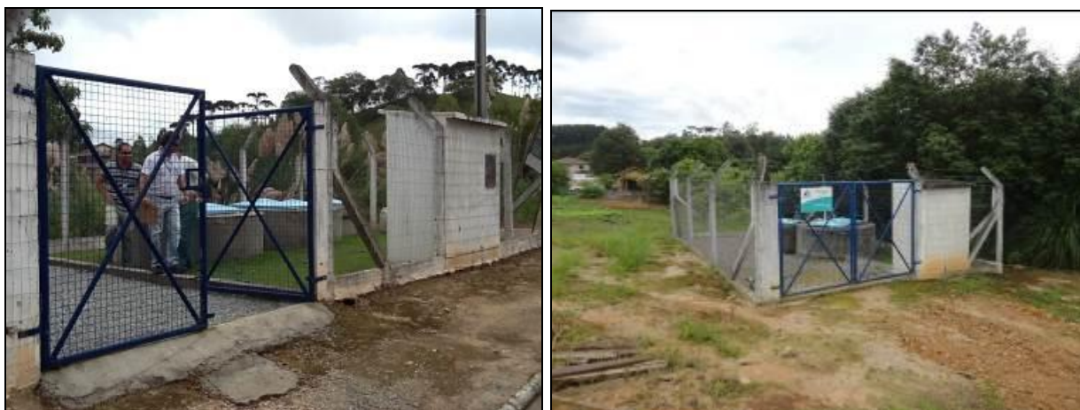
Figura 53: Estação Elevatória EE-02 (Inicial à esquerda – Acompanhamento à direita)
