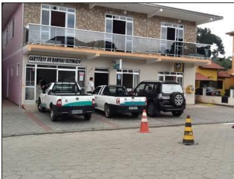
Figura 1: Vista geral da Fachada
