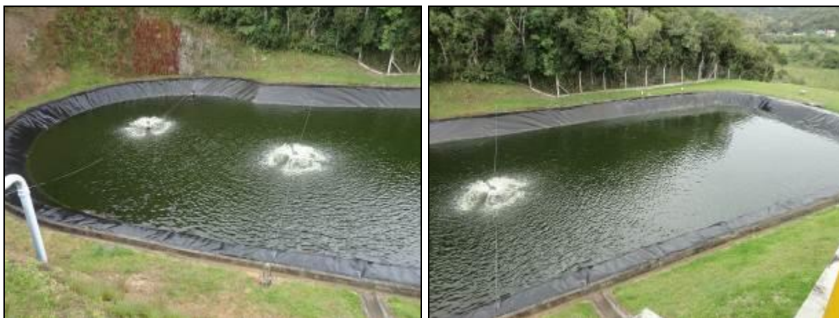
Figura 49: Lagoas de aerção e decantação (Acompanhamento)
