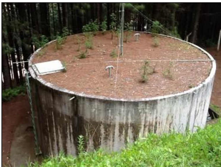
Figura 29: Reservatório R-01 Sede (Inicial)
