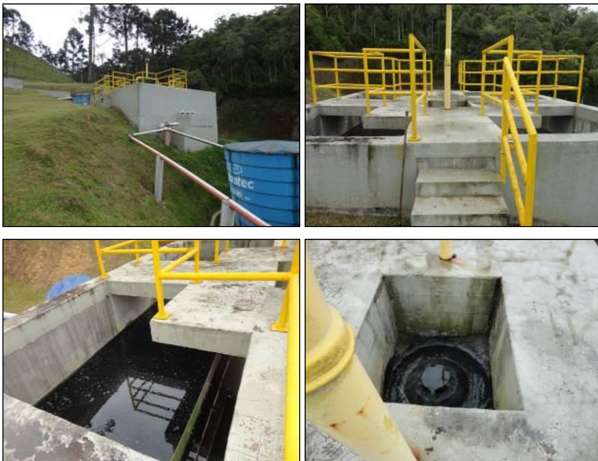
Figura 40: Vista geral das estruturas da ETE (Acompanhamento)
