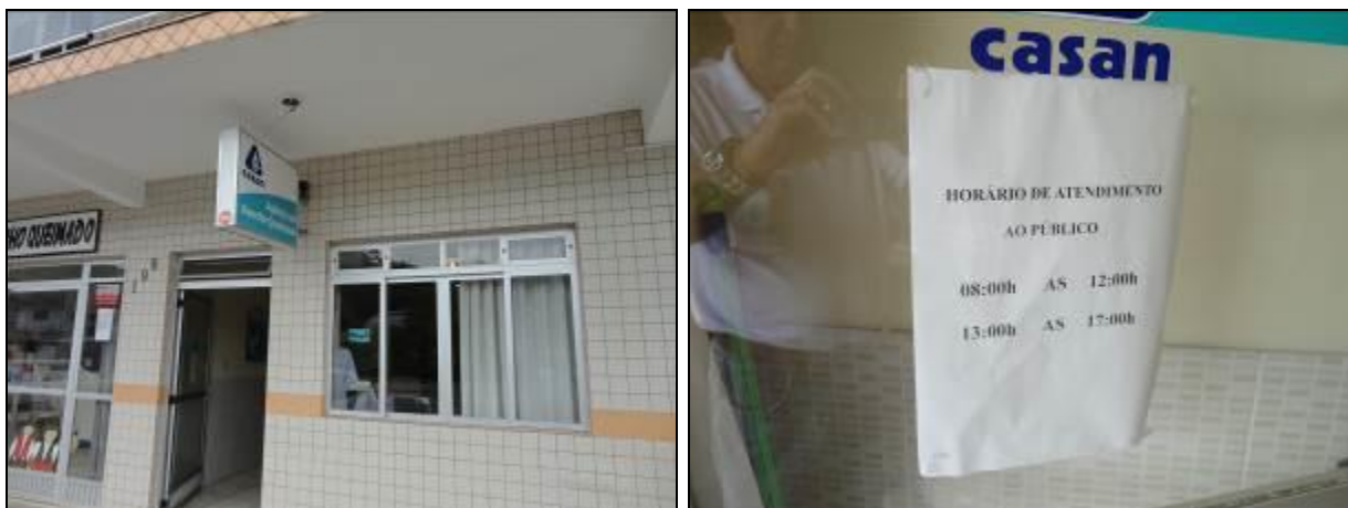
Figura 3: Fachada do prédio (Acompanhamento)
