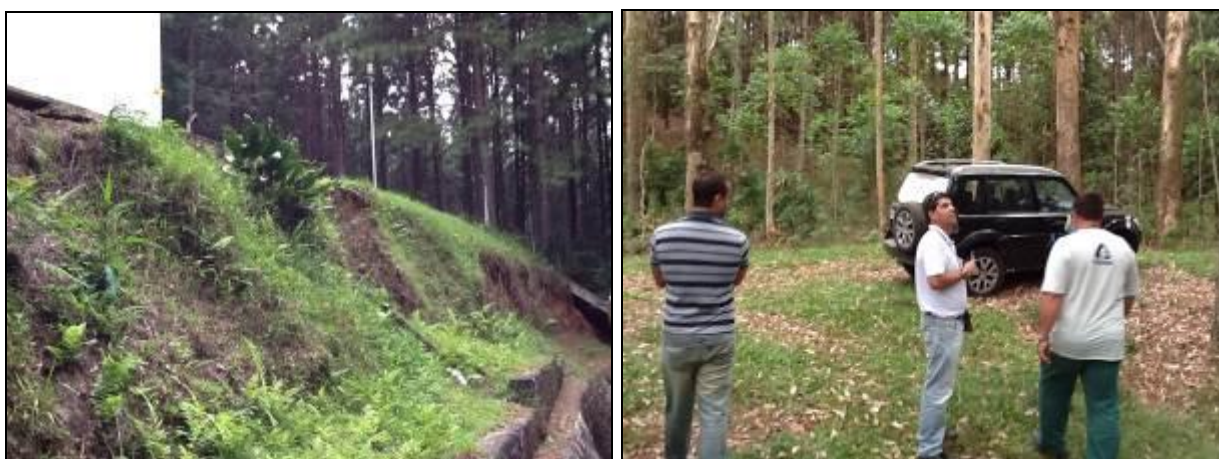
Figura 28: Áreas externas da ETA Sede (Inicial)
