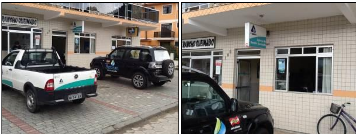
Figura 2: Fachada do Prédio (Inicial)
