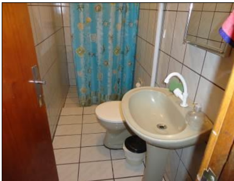
Figura 7: Sanitário da Unidade (Acompanhamento)
