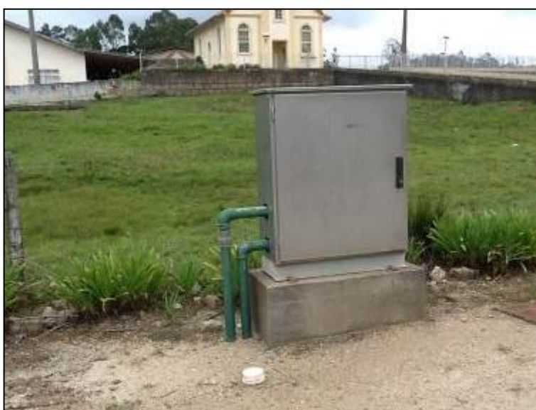
Figura 37: ERAT sem isolamento (Inicial)
