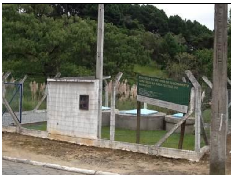
Figura 54: Estação Elevatória EE-03 – Portal (Inicial)
