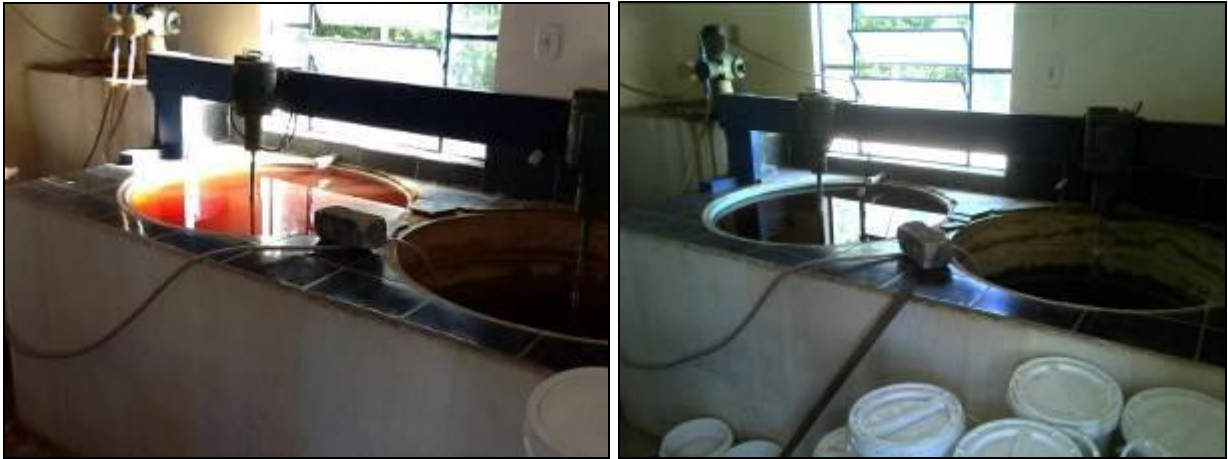
Figura 14: Casa de Química da ETA (inicial e acompanhamento)
