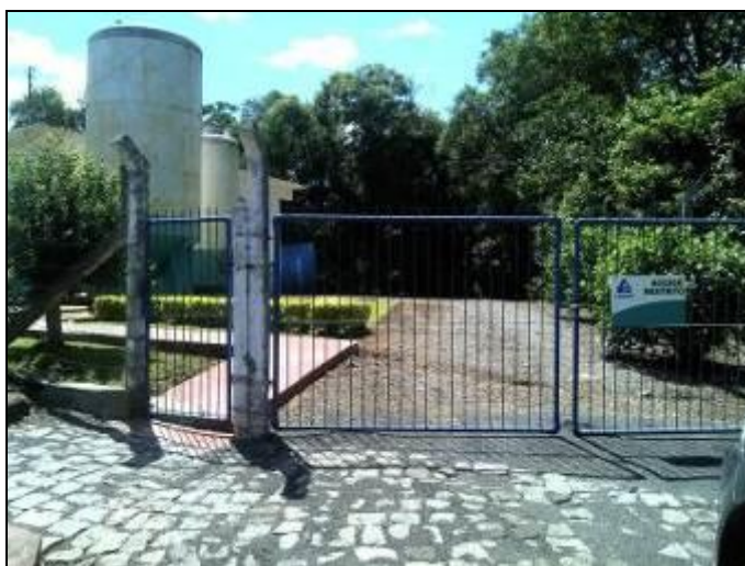
Figura 13: Área da ETA cercada (acompanhamento)
