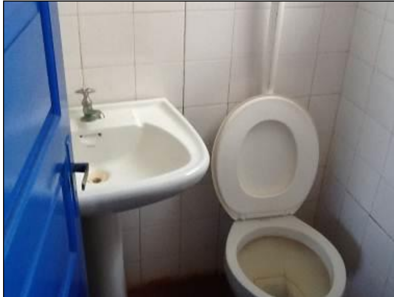
Figura 3: Sanitário da Agência
