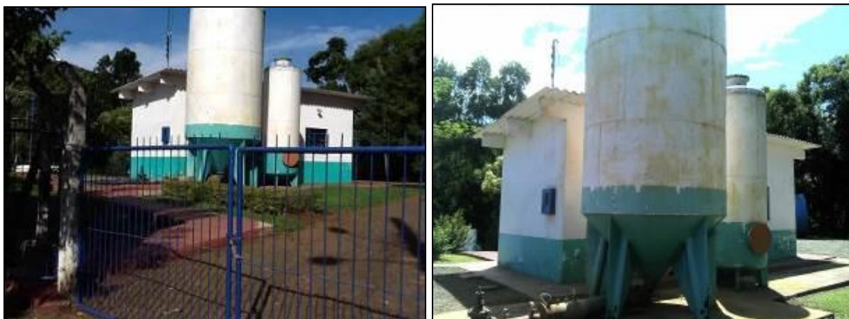
Figura 9: Fachada da ETA (inicial e Acompanhamento)
