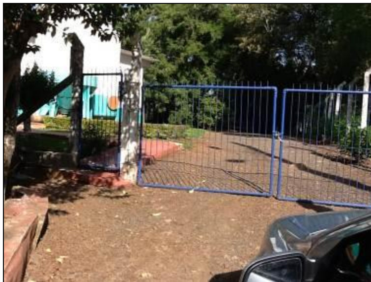
Figura 10: Acesso de entrada da ETA
