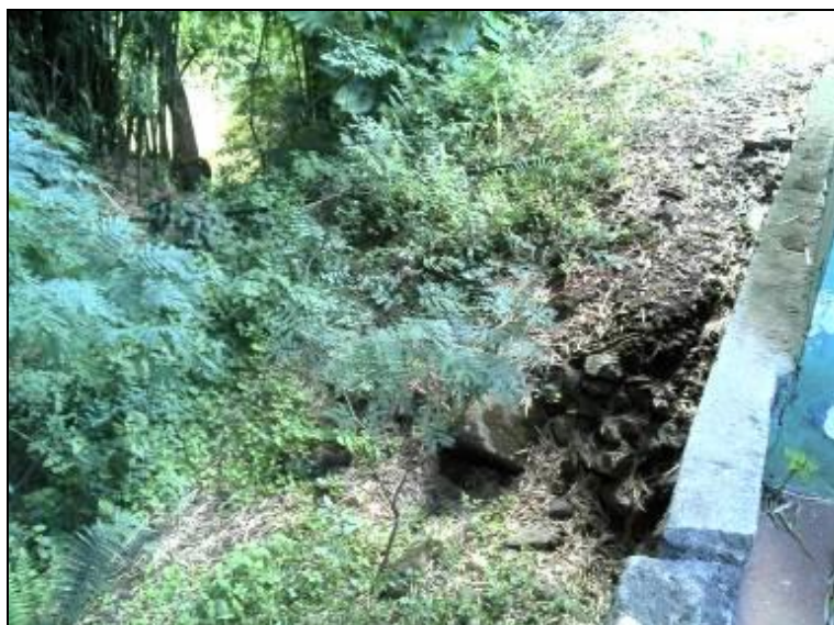
Figura 8: Acesso a Captação (acompanhamento)
