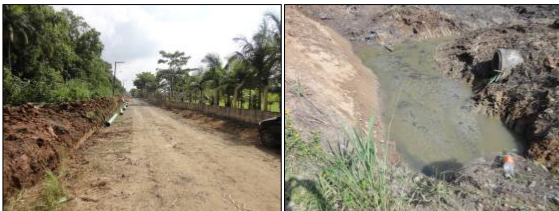
Figura 1: Obras de captação superficial na Rua das Carpas (Itinga)
