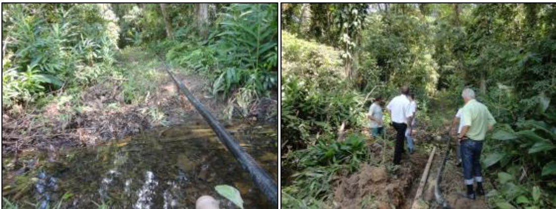
Figura 3: Obras de captação superficial no Loteamento Mario Dunze
