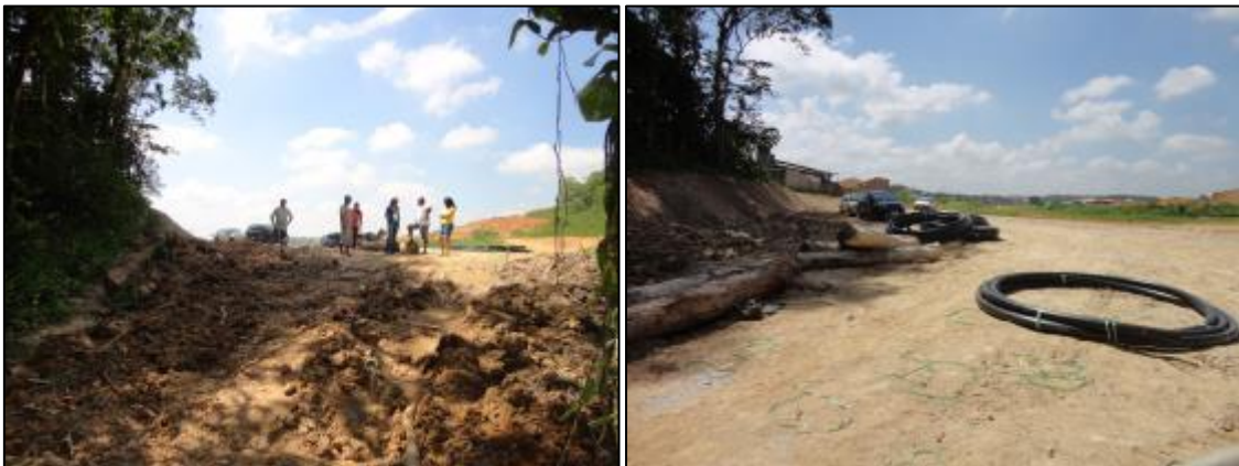
Figura 4: Obras de captação superficial no Loteamento Mario Dunze
