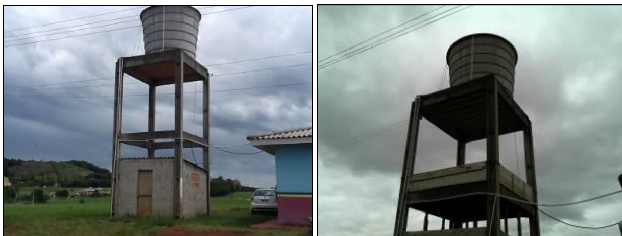
Figura 11: Reservatório Área Industrial
