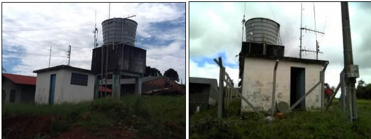
Figura 13: Reservatório Marombas (inicial e acompanhamento)
