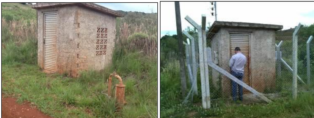
Figura 4: Poço 2 - (inicial e acompanhamento)
