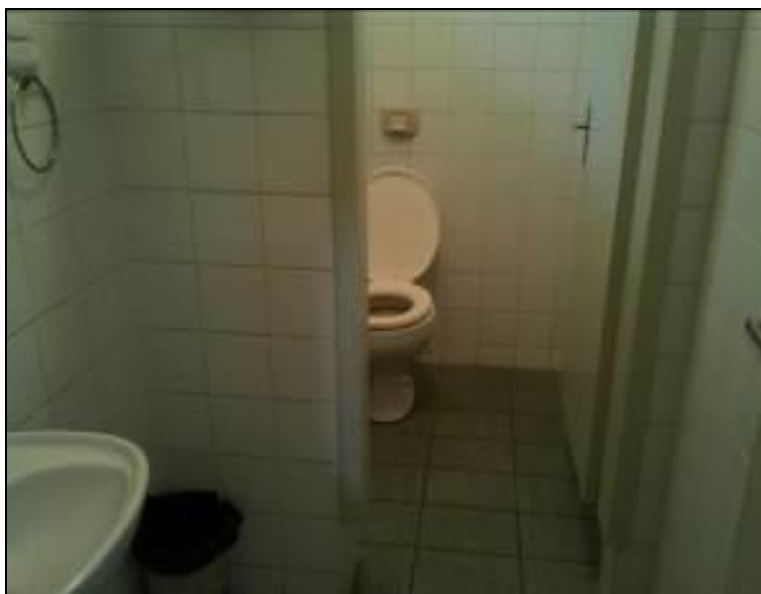
Figura 5: Sanitários da Unidade (acompanhamento)
