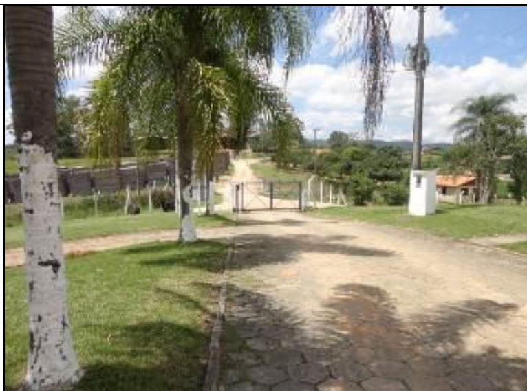
Figura 16: Vista da ETA cercada
