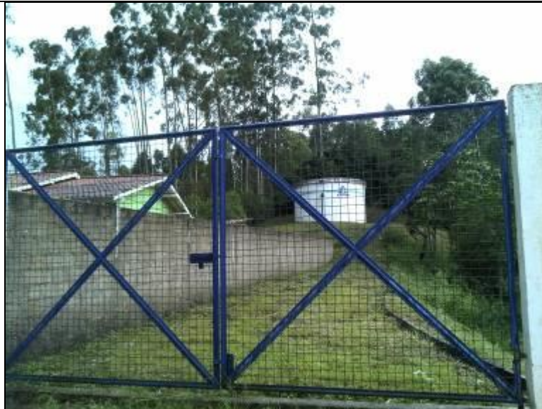
Figura 23: Reservatório R-03 (Inicial)
