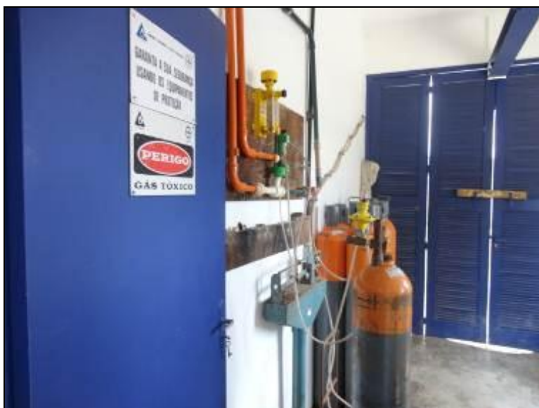
Figura 21: Guarda dos produtos químicos
