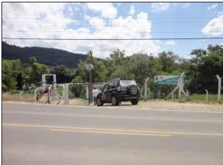
Figura 11: Acesso a Captação
