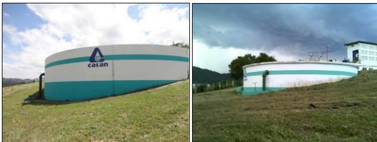
Figura 22: Reservatório R 01 e R 02 (inicial e Acompanhamento)
