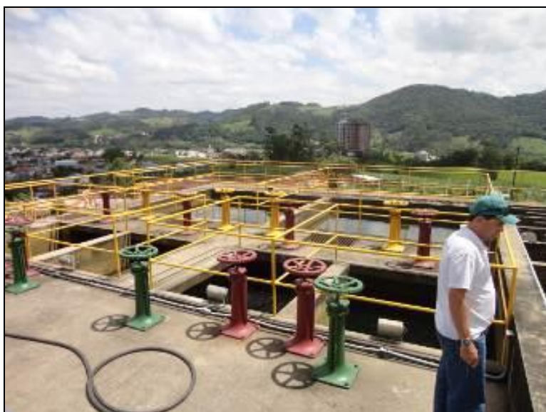
Figura 17: Guarda corpos da ETA
