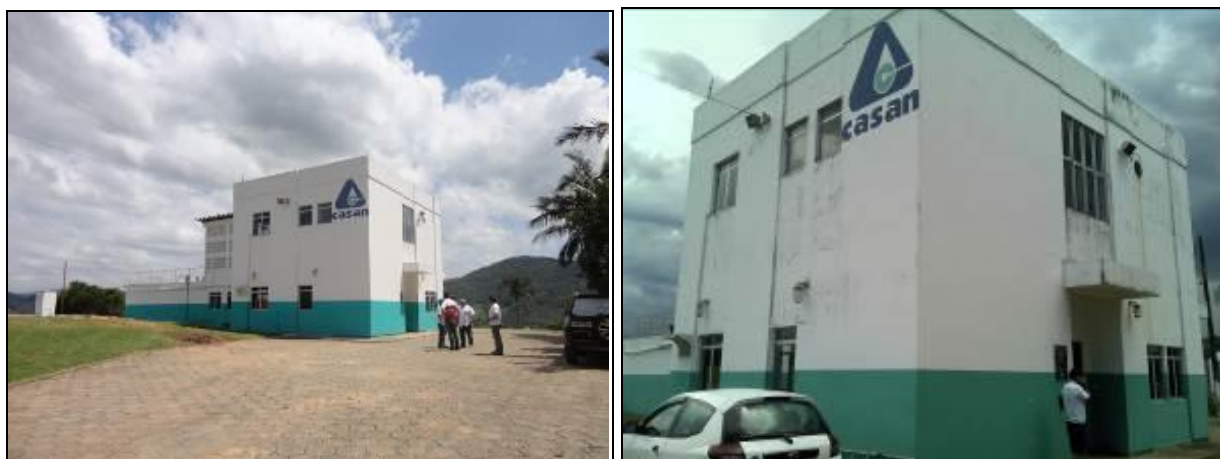
Figura 14: Fachada da ETA (inicial e acompanhamento)
