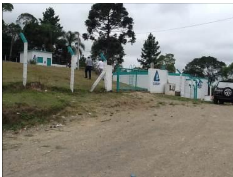
Figura 18: Acesso aos reservatórios centrais
