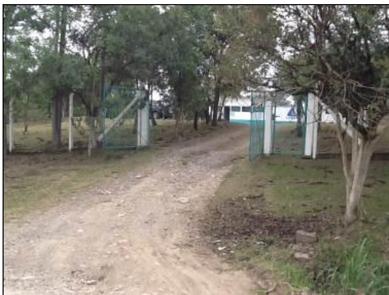
Figura 8: Acesso a Captação
