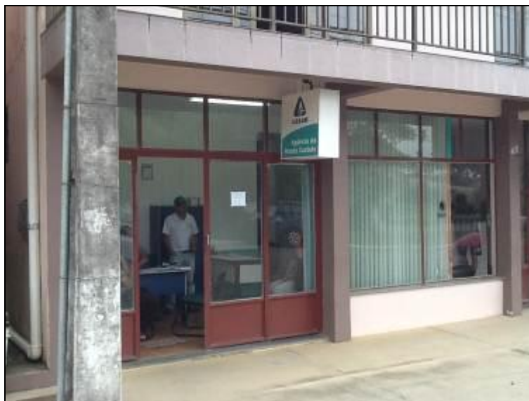
Figura 1: Fachada do Prédio
