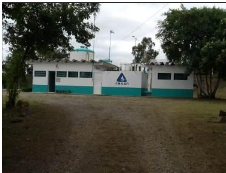
Figura 11: Proteção da ETA e Conservação.
