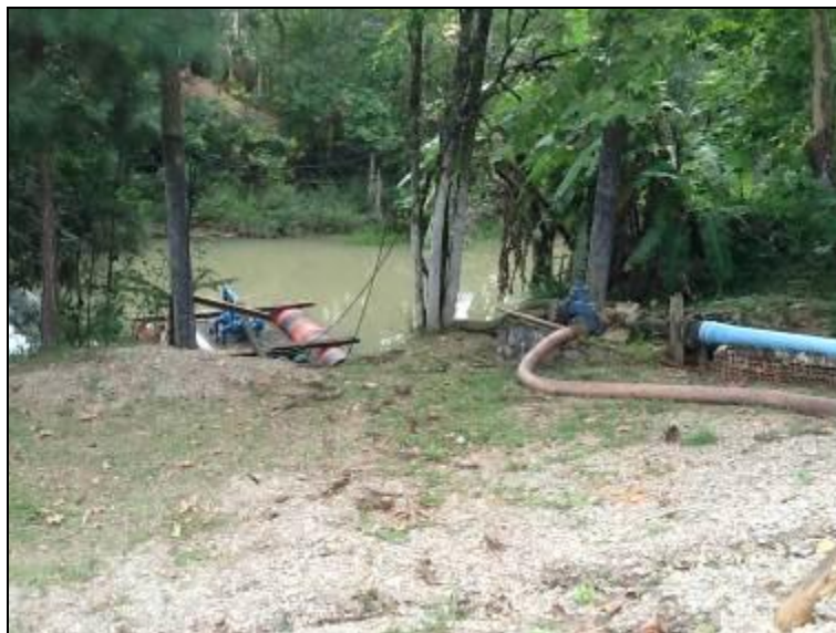
Figura 7: Área de captação sem isolamento.
