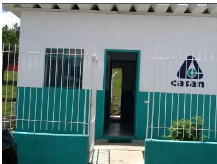
Figura 1: Fachada do Escritório Local
