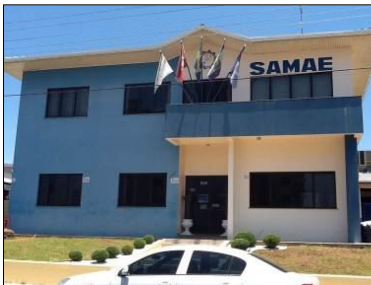
Fachada do Escritório.
