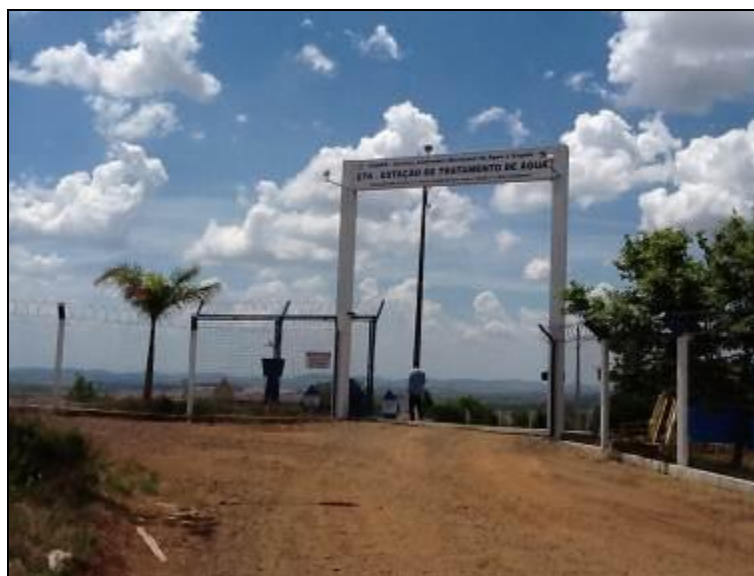
Acesso à ETA
