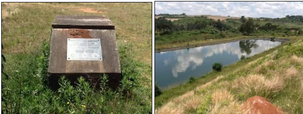
Estação de tratamento de Esgotos secundária.
