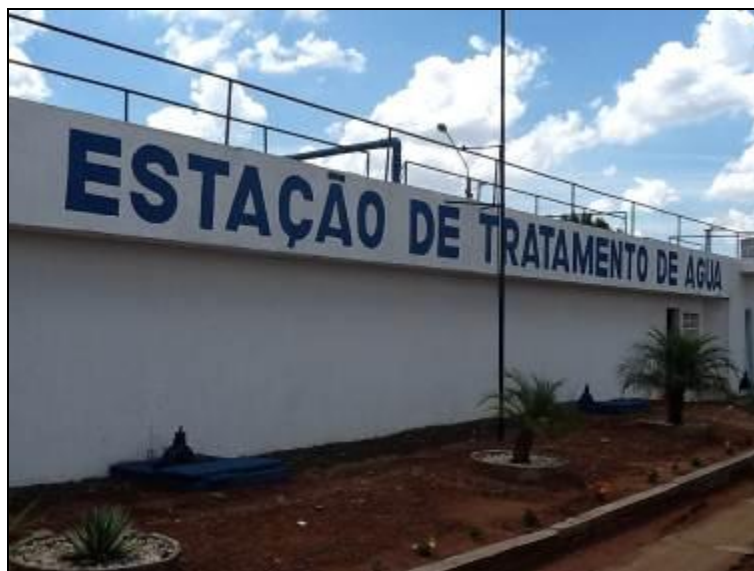
Fachada da ETA
