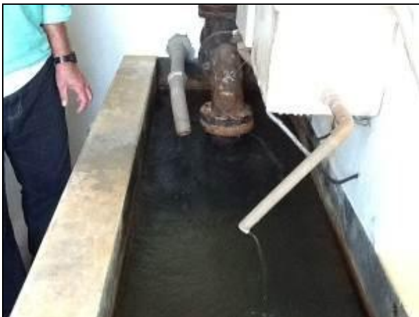
As áreas de tratamento químico da água: apenas aplicação de cloro e flúor por ser água de poço.
